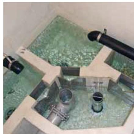
In der Brunnenstube einer Quellfassung wird das Wasser aus den Sickerleitungen gesammelt.
