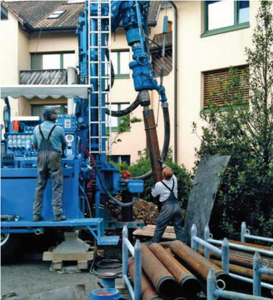
Bohrung für einen Grundwasser-Entnahmebrunnen zur Beheizung eines Wohnhauses.
