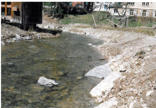
unmittelbar nach Bauausführung
