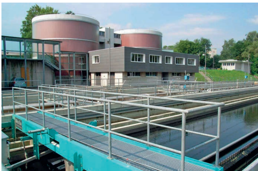
Faultürme der ARA Wil: Hier wird der flüssige Schlamm ausgefaut. Dabei entsteht Klärgas, das zur Stromproduktion verwendet wird.
