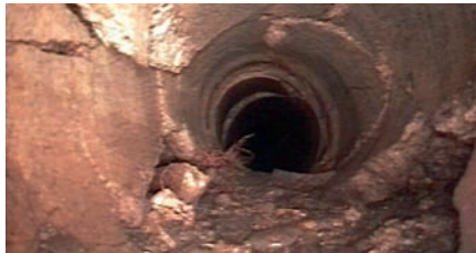
Defektes Kanalisationsrohr
