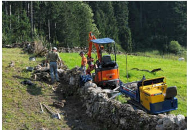
**Abb. 102: Erneuerung eines Teilstücks im vorderen Bereich der Mauer**
