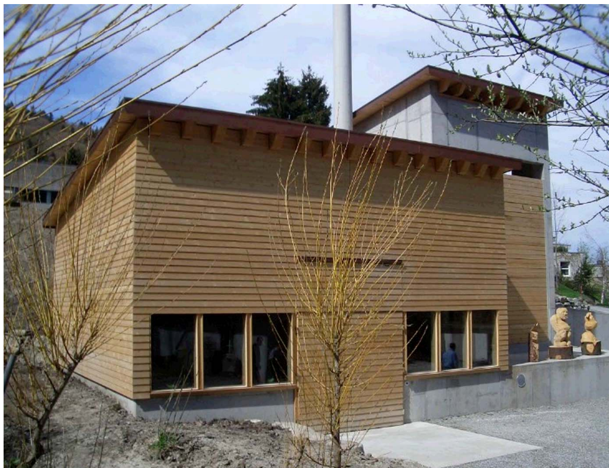
Abbildung 13: Bad Unterrechstein, Schnitzelheizzentrale (Foto: Hansruedi Ammann, Thal)
