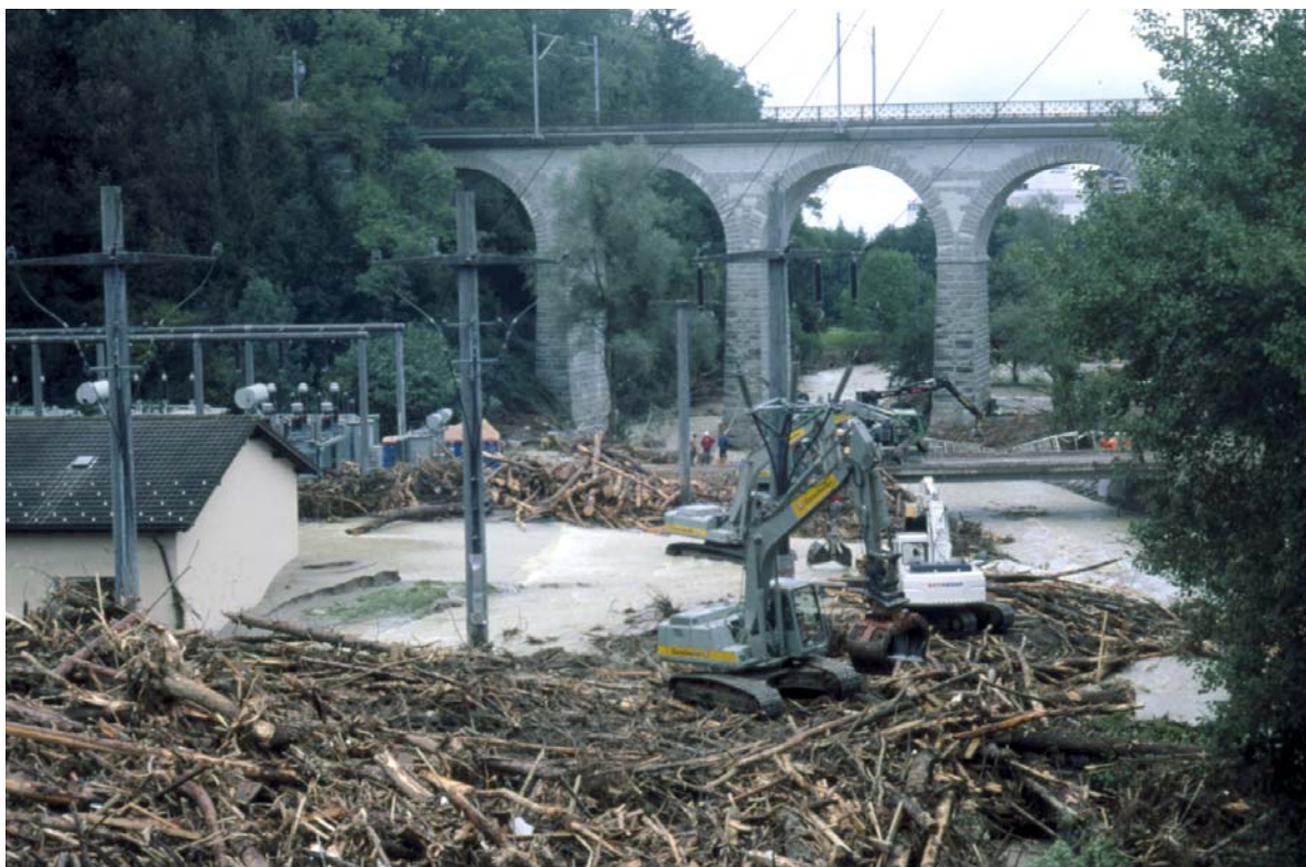
Abbildung 12: SAK-Unterwerk Goldach, Hochwasserschäden durch Schwemmholz Sommer 2002 (Foto: Josef Zoller, Rorschach).
