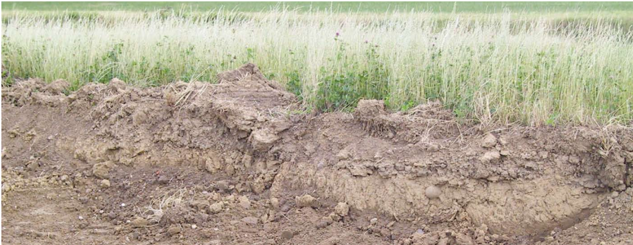
Abhumisierung für den Bau einer Strasse
