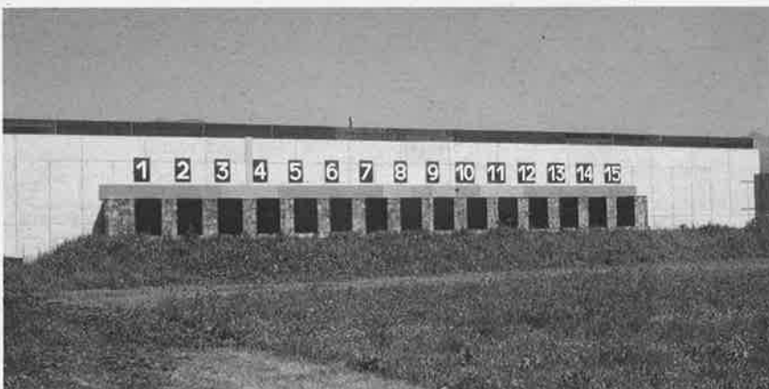
Bei der Schiessanlage «Hädler» in Altstätten wurde ein emissionsarmer technischer Kugelfang erstellt (Bilder: AFU).
