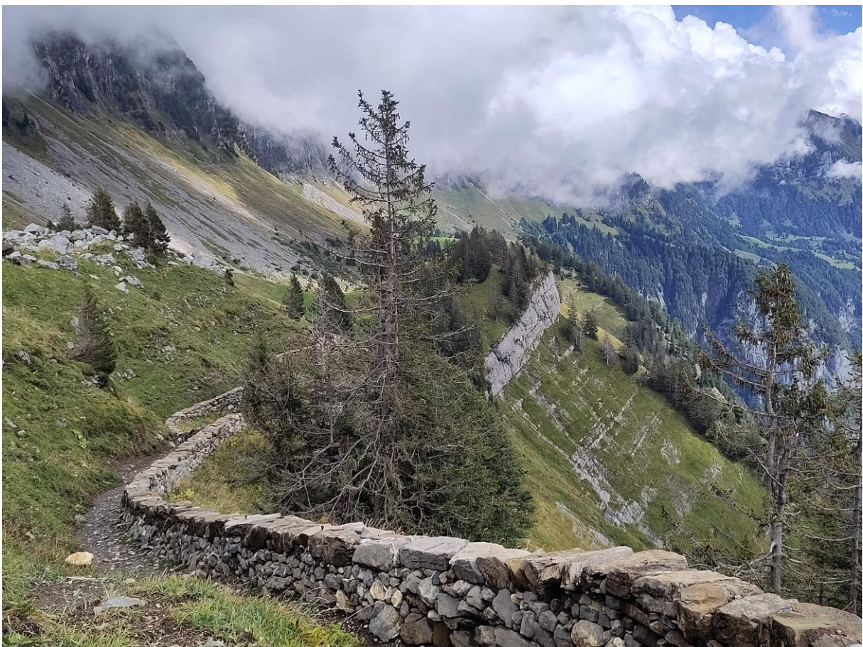
Sanierte Trockenmauer Alp Schrina Walenstadtberg: © ANJF
