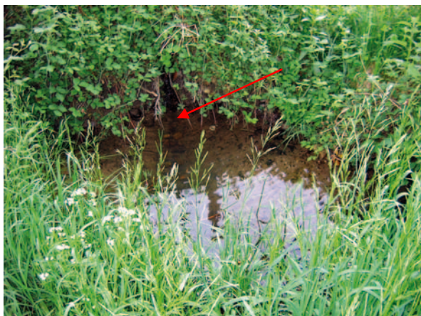
Abb. 3 > Entwässerungsrohr mit anschliessend offenem Graben
