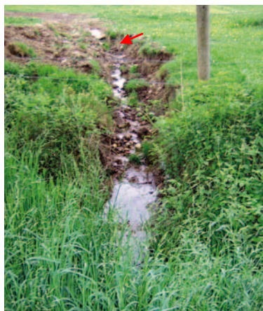
Abb. 4 > Entwässerungsrohr mit einer Senke am Ufer
