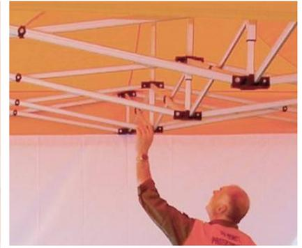
6. Giebel von Hand in die Endposition nach oben schieben, bis der Druckknopf einrastet.
