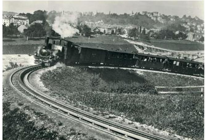
Appenzeller Strassenbahn im Ruckhalde-Rack um 1901. Vorgespannt ist eine der vier Dampflok des Typs HG 2/3, die als erste Vierzylinder-Verbundlokomotiven ebenfalls eine Weltneuheit darstellten. Die Elektrifizierung der Strecke erfolgte 1931.
