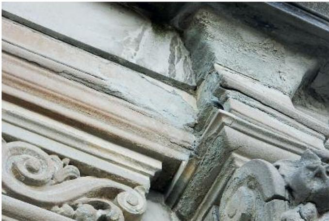
Typisches Schadensbild: Wasser dringt in Risse und undichte Fugen ein und führt zu Abplatzungen. Die anhaltende Bewitterung bewirkt weiter das Absanden des Gesteins.
