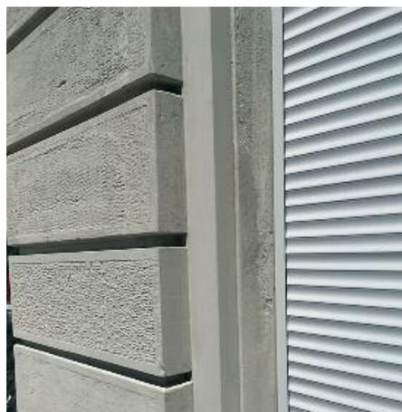
Aufgrund der unterschiedlichen Farbigkeit der Flickstellen und den Rückständen der alten Mörtelschwemme wurden die Steinflächen mit einer wässrigen Lasur farblich eingestimmt.
