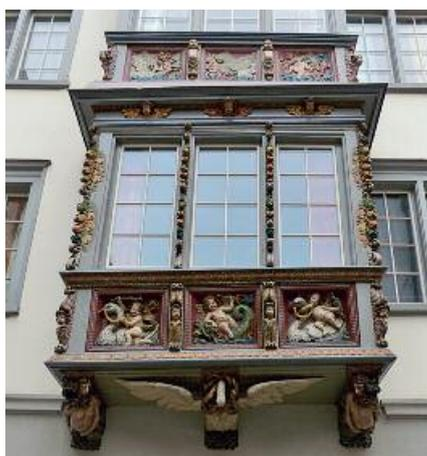
Schwanen-Erker nach der Renovation. Nach der Reinigung mit warmem Wasser wurden die losen Farbschuppen vorsichtig entfernt, morschtes Holz und nicht mehr haftender Kitt entfernt und nachgeschliffen, anschliessend mit transparentem Imprägnieröl grundiert und die Flickstellen mit Ölkitt geschlossen. Vor dem zweimal dünn aufgetragenen Abschlussfirnis mussten die Fehlstellen mit Ölfarbe geschlossen und wenige Teile retuschiert werden.
