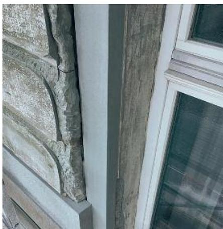
Die Sanierung der Natursteinpartien erfolgte im wesentlichen auf drei Ebenen: stark schadhafte Stellen an den Mauersteinen und Fenstereinfassungen sind mit Rorschacher Sandstein ersetzt worden.
