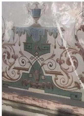
Zustand nach dem Entfernen der losen Farbe und dem Anschleifen des Untergrunds, vor dem Retuschieren.
