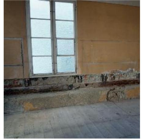
Das Gebäude ist über einem massiven Kellergemäuer aus Bruchsteinen in einer Pfosten-Riegelkonstruktion erstellt. Problemzone bildet die Holzschwelle, welche direkt auf dem Bruchsteinmauerwerk liegt und nicht vor aufsteigender Feuchtigkeit geschützt ist.
