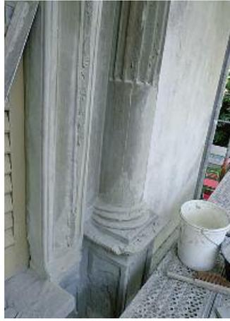
Sandsteinrestaurierung: Aufmörtelung und Reprofilierung einer Halbsäule, auch um den Zerfall der Substanz zu verlangsamen.
