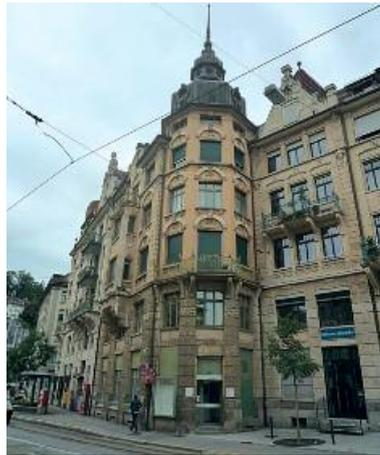
Zustand der Fassaden vor der Renovation. Neben der starken Verschmutzung und den störenden Schaufenstereinbauten wurden auch die nicht mehr originalen Fenster ersetzt.
