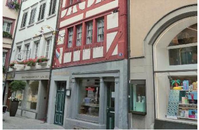
Riegelfassade des Bäumli wie sie bei der Renovation 1976 wieder hervorgeholt und restauriert wurde. Zu erkennen ist die leichte Ausbuchtung über dem Reihenfenster im 1. Obergeschoss, welche wohl massgeblich für den nun behobenen Bauschaden verantwortlich war.
