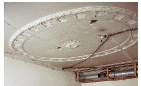
Von der Stuckdecke kam dieser stark beschädigte Rest zum Vorschein; hinten ein Rohr der Warmluftheizung.
