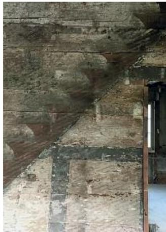
Neben dem Abdruck einer Blockstufentreppe aus der Bauzeit ist auch ein auf die Strickwände aufgemaltes, grau gefasstes Riegelwerk aus der Barockzeit zu erkennen. Die anschliessende Türöffnung ist eindeutig später eingefügt worden.
