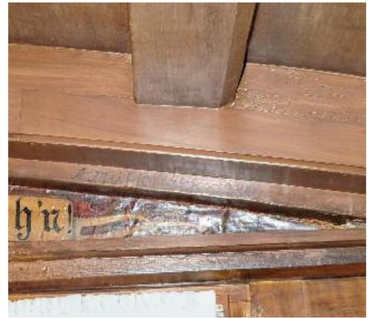
Ansicht nach Abschluss der Arbeiten. Zu erkennen sind die Aufdopplung zum Schutz der Balkenköpfe und die ergänzte Fassung der Maserierung.
