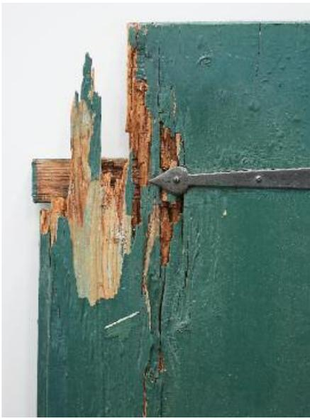
Bauteilschutz durch Farbanstrich. Eine der Hauptaufgaben eines Farbanstrichs ist der Schutz des darunterliegenden Untergrundes vor Zerstörung. Bei einer unsachgemässen Kombination von Untergrund und Anstrichmittel kann letztlich ein Anstrich den Untergrund gefährden oder gar zerstören. Beispiel eines Fensterladens: Aufgrund einer falschen Grundierung verfaulte das Holz unter dem weitgehend intakten Anstrich.
