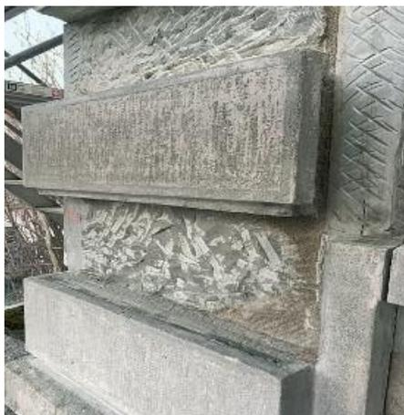
Abplatzungen und stark sandige Stellen konnten mechanisch vorbereitet und anschliessend mit einem mineralischen Mörtel aufmodelliert und formal angepasst werden.
