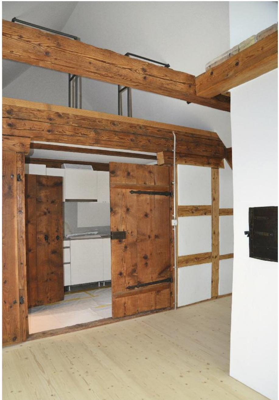
Im Dachgeschoss ist unter Bewahrung der Dachkonstruktion ein kleines Studio eingebaut worden.
