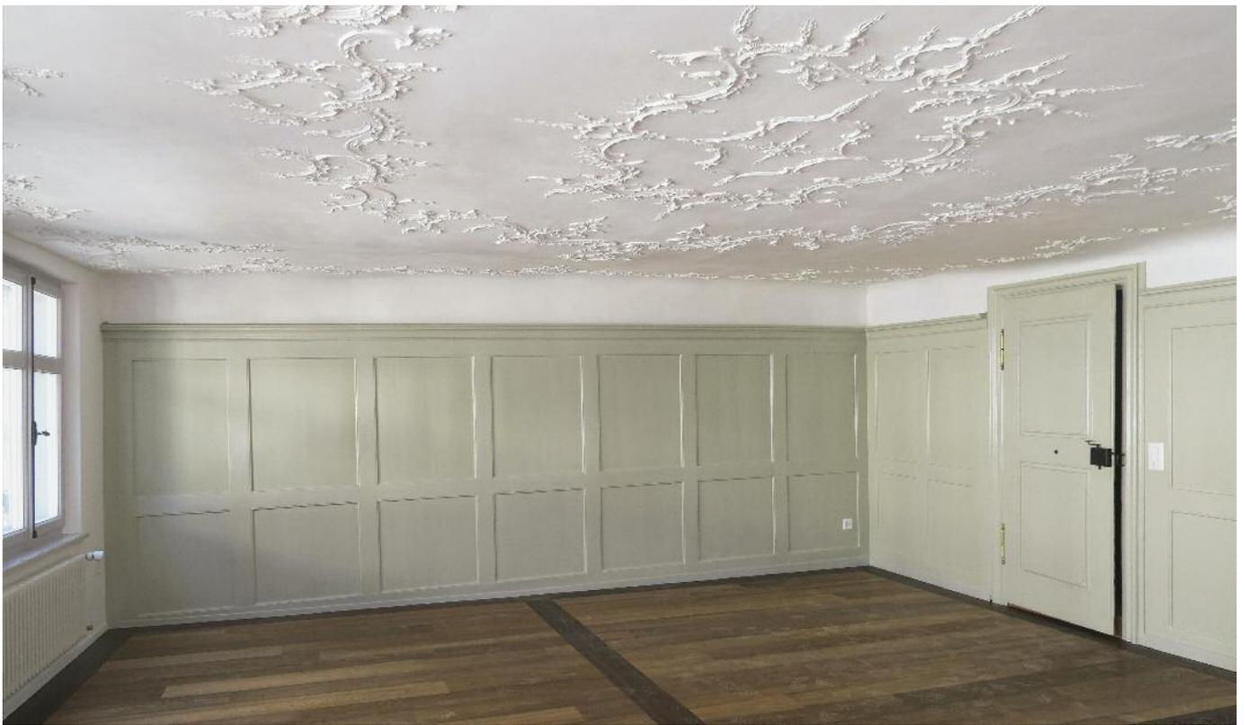
Die restaurierte Stuckdecke im 2. Obergeschoss mit dem zugehörigen, ergänzten barocken Täfer samt Türe und einem passenden neuen Boden.
