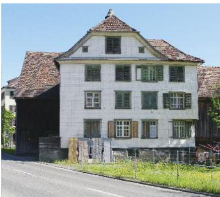
Die Hauptfassade vor der Renovation ohne Vordächer und mit Faserzementplatten verkleidet.
