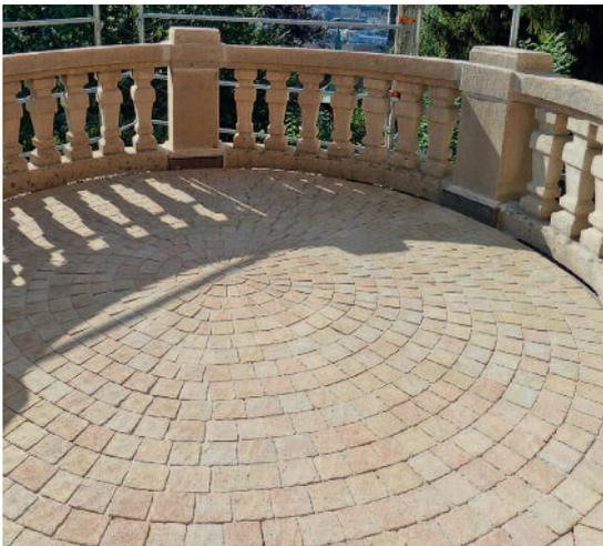
Der Bodenbelag auf der Terrasse stammte bereits nicht mehr aus der Bauzeit und musste erneuert werden. Die stark beschädigten Balustraden jedoch konnten durch den Steinmetz repariert werden.
