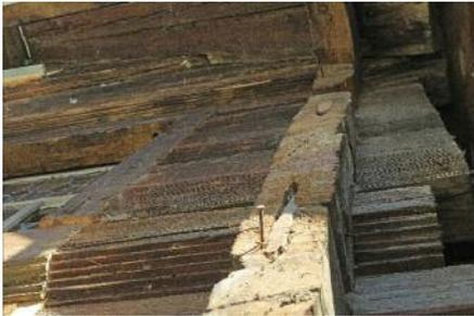
Unter der Fassade aus Faserzementplatten kam die Strickfassade mit Rillenfriesen zum Vorschein.
