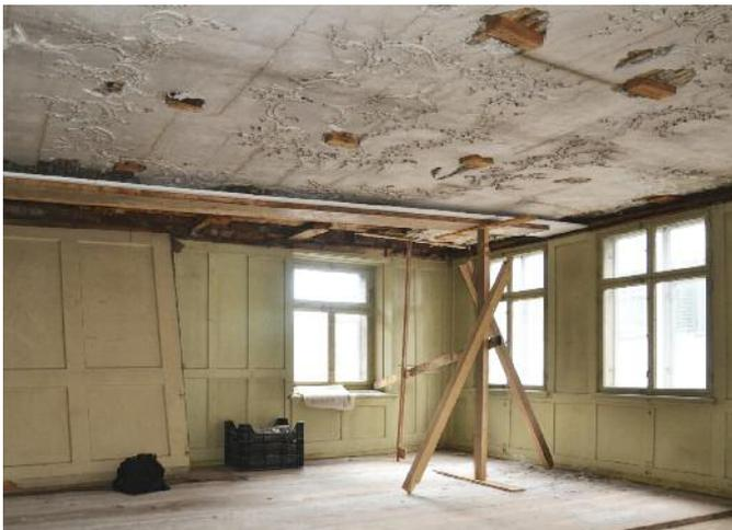
Der zuvor unterteilte Raum nach dem Entfernen der sekundären Trennwand und des Deckentäfers aus dem 19. Jahrhundert.
