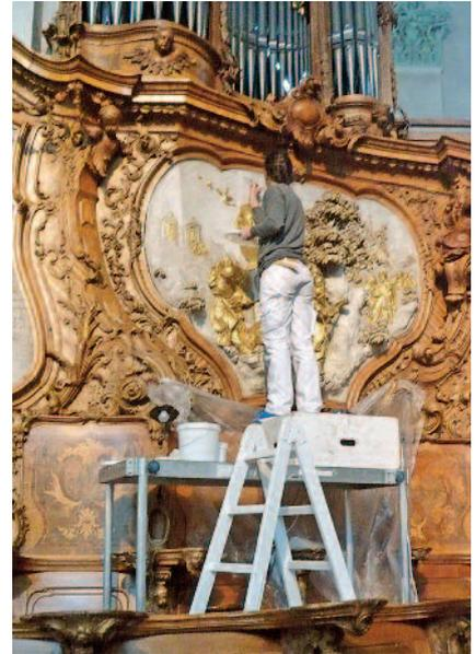
Die Statuen und Reliefs werden im Trockenverfahren gereinigt. Danach folgt eine feucht-trockene Nachreinigung.
