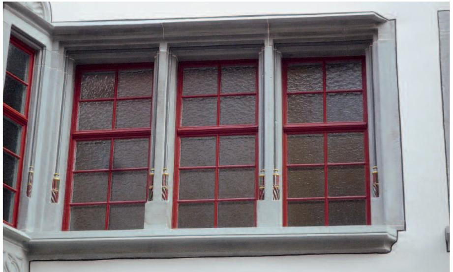
Spätgotische Reihenfenster aus der Bauzeit um 1580 mit Kehlen und Rundstäben profiliert, welche aus geschraubten und mit Perlschnüren besetzten Basen wachsen.
