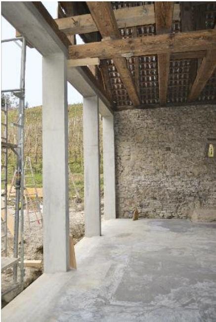
Der Einbau des Stahlbetonrahmens der Westfassade.
