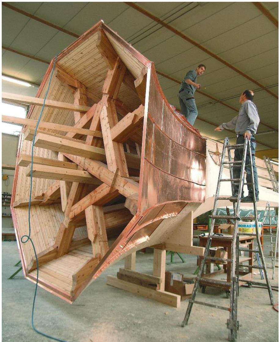
Die Rekonstruktion des Dachreiters wird mit Kupfer eingekleidet.
