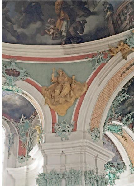
Die Reinigung der Deckenmalereien erfolgt mit Feinhaarpinsel und Feinstaubsauger. Die rechte Bildhälfte ist hier noch in ungereinigtem Zustand.
