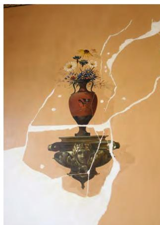
Die vorhandene Dekorationsmalerei an den Wänden mit Vasen, Strickband und Bänderung wurde in Feinarbeit von den Stuckateurinnen zusammengesetzt und anschliessend durch die Restauratoren ergänzt.
