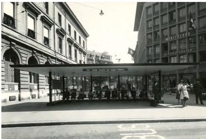
«Trolleybus-Wartealle» am Bahnhofplatz, zwischen Metropal und ehemaligem Rathaus. Die verglaste Eisenkonstruktion sollte den Blick auf den Hotel-Neubau von Otto Glaus ermöglichen. Die Wartealle befindet sich seit der Umgestaltung des Bahnhofplatzes Ende der 1970er Jahre bei der Haltestelle «Kantonsspital» stadtauswärts.
