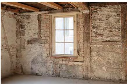
Im dritten Obergeschoss zeichnete sich an der Westwand die frühere Dachschräge ab (unten links im Bild), im Mauerwerk darüber wurden Dachziegel als Stopfmateriale verwendet. Foto: Peter Albertin, Winterthur.
