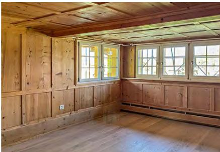
Der Boden der heimeligen Stube wurde abgesenkt, um die notwendige Raumhöhe zu schaffen. Dies wird im Übergang zum Fussboden sichtbar, wo das Täfer ergänzt werden musste.
