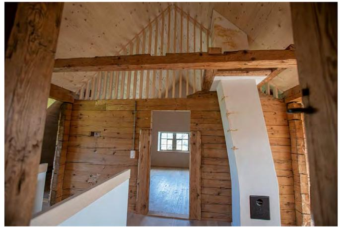
Um mehr Raum zu erhalten, wurden in der Firstkammer die Deckendielen entfernt. Eine Teilverschalung zum Vorraum schafft eine lichtbringende Trennung.
