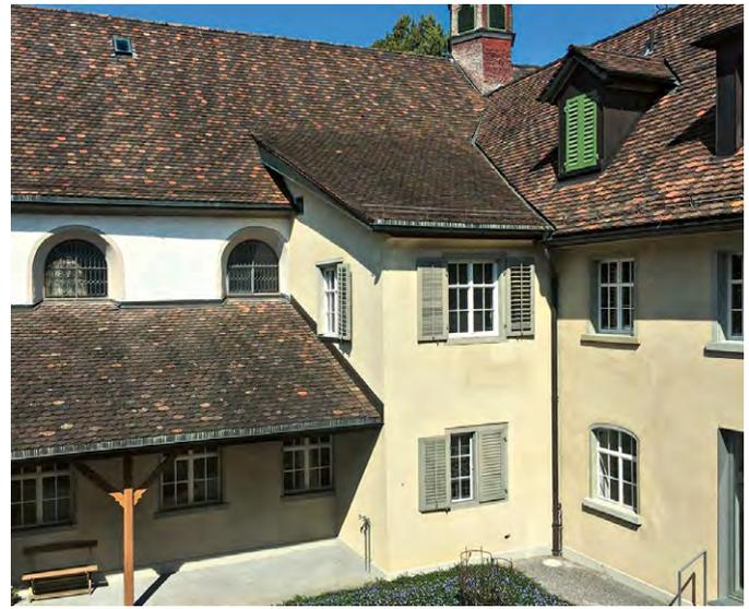
Das neue Oratorium mit dem Oblicht entstand im Obergeschoss des früheren Annexbaus mit Pultdach. Darüber der restaurierte Dachreiter mit dem Zwiebelhelm.
