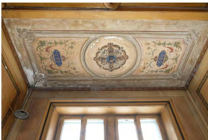
Eines der typischen Schadensbilder: vergilbte Malereien mit abgeplatzten Farbfassungen, Verfärbungen aufgrund durchschlagender Flecken, Verschmutzungen und jüngere unsachgemässe Überfassungen.
