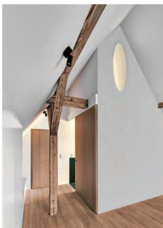
Die tiefgreifendsten Eingriffe im Bestand fanden im bisher sehr einfach ausgebauten Dach statt – unter Erhalt der ursprünglichen Dachkonstruktion.
