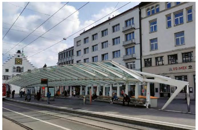
Die grösste und bedeutendste Wartealle in St.Gallen wurde 1996 von Santiago Calatrava als Druckbogenträger in Stahlkonstruktion mit vorgespannter Betonfundation errichtet. Sie ist nicht bloss ein ingenieurtechnisches Meisterstück, absolut leicht und filigran, sondern auch eine touristische Sehenswürdigkeit und ein sozialer Treffpunkt.
