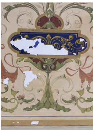
Schadhaftes Deckenbild mit partiellen Abplatzungen. Die bestehende Malerei wurde in den Anschlussbereichen mit Leimlösung hinterspritzt und die Fehlstellen farbtunnah rekonstruiert.
