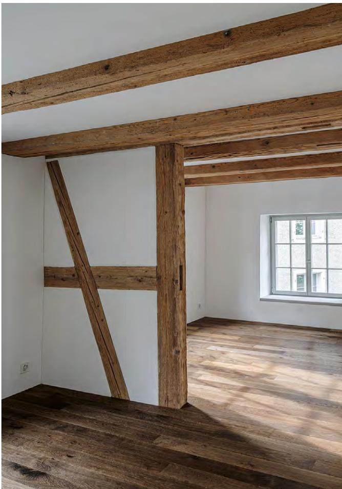
Im zweiten Obergeschoss prägen die langen, von Fassade zu Fassade gespannten ehemaligen Dachbalken die Wohnung.
