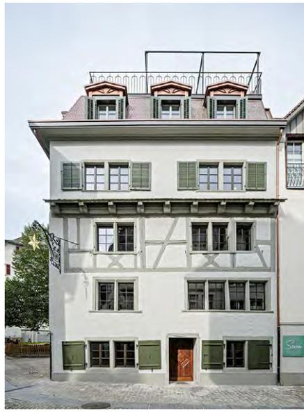
An der renovierten Fassade lässt sich die Baugeschichte weiterhin ablesen: an zwei gemauerten Geschossen von 1564, einem Fachwerkgeschoss von 1668 und der Aufstockung um 1900.
