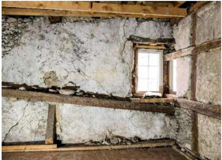
Westwand im Obergeschoss mit Mauerwerk von 1484, horizontalem Ankerbalken aus dem 17. Jahrhundert und darüber, auf dem älteren Verputz, die gelbe Fachwerkmalerei von ca. 1650. Rechts die Binnenwand ebenfalls von 1650. Foto: Klaus Engler, Untereggen.
