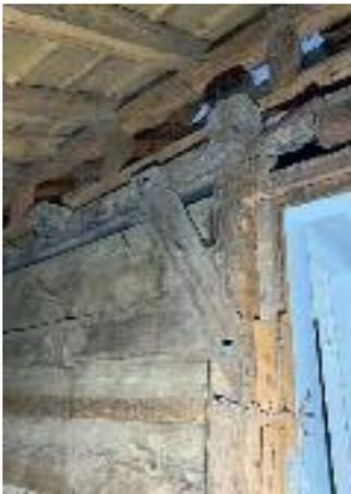
Typisches Merkmal für die Holzgerüstbauweise sind die sogenannten «Kopfbänder», welche Ständer und Balken verbinden und aussteifen. Die Art der Verbindung, die Stärke und der Winkel dieser Hölzer verraten häufig ihr ungefähres Alter.
