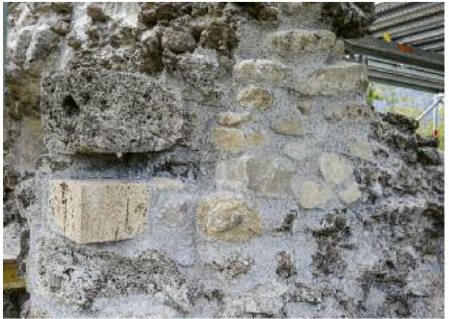
Intakte Quaderecke und rekonstruierte Ecke, die neuen Steine sind deutlich als Zutat zu erkennen.
