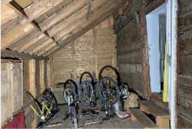
Die eigentliche Fundgrube war der Dachraum des nördlich angebauten Schopfs. Hier lag die Konstruktion des Ständerbohlenbaus frei und zeigte deutlich die beiden Bauphasen, die anschliessend ins 15. und 16. Jahrhundert datiert wurden.
