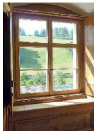
Ein grosses bauliches Problem stellte die hohe Luftfeuchtigkeit während und nach dem Einbringen des neuen Deckenputzes dar. Dies führte auch dazu, dass die rund fünfzig jährigen Fenster ersetzt werden mussten.
