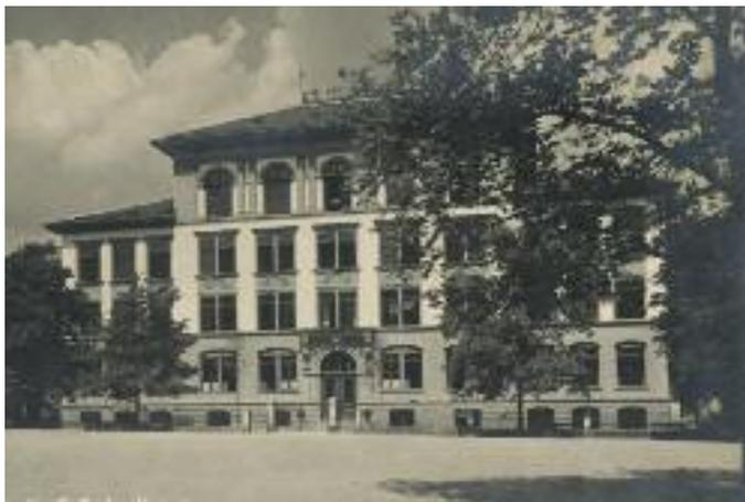
Abbildung des Talhof Schulhauses kurz nach der Fertigstellung 1892. Der kräftige Mittelrisalit mit bossiertem Sockelmauerwerk, profilierten Brüstungsplatten und kräftigen Fensterüberdachungen wird mit einer Arkade von fünf Rundbogenfenstern zwischen Doppel-Blendsäulen abgeschlossen.
