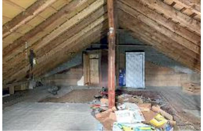
Im Dachgeschoss offenbarte sich, dass das Haus früher ein flacheres Dach besass, ein sogenanntes Tätschdach, das typisch für mittelalterliche Hausbauten ist. Die Dacheindeckung bestand dabei aus Brettschindeln, die nicht festgenagelt, sondern mit Latten und Steinen beschwert wurden. Der obere, mit Schindeln gedeckte Teil des Giebels muss also einmal aussen freigelegt haben, bevor das heutige Dach errichtet wurde.
