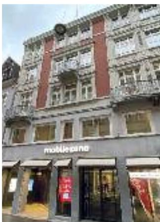
Fassade nach der Renovation 2019. Nach der Restaurierung der Sandsteinpartien wurden diese grundiert und mit einer deckenden, diffusionsoffenen Mineralfarbe gestrichen. Aufgrund vieler Flickstellen konnte das Ziegelwerk nicht befriedigend freigelegt werden und wurde ebenfalls mit einer Mineralfarbe im Ziegelton gefasst.
