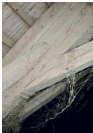
Der Dachstuhl überzeugt durch eine hohe handwerkliche Fertigung und einen ausgeklügelten Abbund, der den grossen stützenfreien Heuraum erst ermöglichte. Als barocker Dachstuhl ist er einzigartig in St.Gallen.
