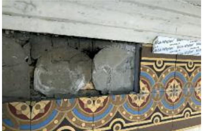
Zwischen Dachuntersicht und Sichtbacksteinmauerwerk befindet sich ein zweireihiger Fries aus Ornamentkacheln. Die Platten wurden in der Vergangenheit mit verschiedensten, zweifelhaften Methoden gesichert – Klebeband, Silikon und dergleichen. Diese Sicherungsmassnahmen wurden wieder entfernt, die losen Platten sorgfältig gelöst und neu fixiert und schliesslich mit einer Klammer gesichert.
