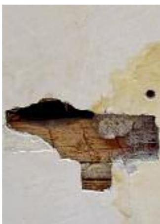
Die Putzsondierung im Bereich des Wasserschadens führte einerseits zu der Erkenntnis, dass Teile der Decke mit einer punktgeschweissten Drahteinlage bereits früher saniert wurde und dass andererseits zwischen der Unterkonstruktion und der Putzschicht ein Abstand von bis zu 1.5 cm bestand.
