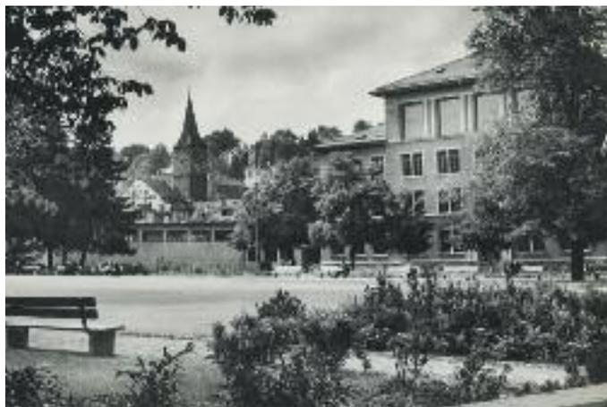
Fassadenrenovation von 1936. Ganz dem damaligen Architektur-trend folgend wurden die Fassaden von jeglichem unnötigen «Firlefanz» befreit. Die hölzernen Rundbogenfenster im Dachgeschoss verschwanden ebenso zugunsten einer grossflächigen Verglasung mit schlanken Metallrahmen. Zwischenzeitlich sind das Sockelgeschoss wieder hervorgehoben und die Mauerflächen hell gestrichen.
