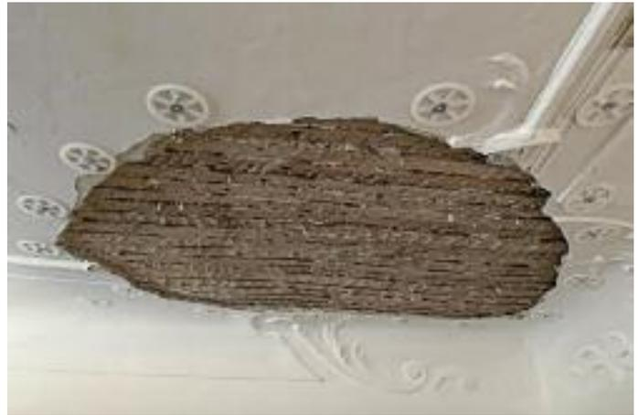
Schadstelle in der Stuckdecke. Da die Ursachen vielschichtig sein können (Erschütterungen, Ermüdungen, Wasserschaden etc.) ist der Schaden selten vorzusehen. Leider ist durch den Deckenausbruch das Medaillon vollständig zerstört worden und konnte nicht mehr rekonstruiert werden. Auf dem Bild sichtbar ist auch eine Notbefestigung, um weitere Ausbrüche zu vermeiden.
