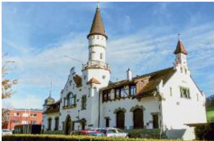
Erhebliche Schäden mussten an der Westseite (Stirnfassade) festgestellt werden. Ein feinsandiger, stark zementöser Sanierungsputz führte zu Rissen in der Fassade und zu Abplatzungen am darunter liegenden Backsteinmauerwerk. Der Verputz wurde grossflächig entfernt und durch einen kalkhaltigen Renovationsputz ersetzt. Damit konnte auch die ursprüngliche Oberflächenstruktur rekonstruiert werden.
