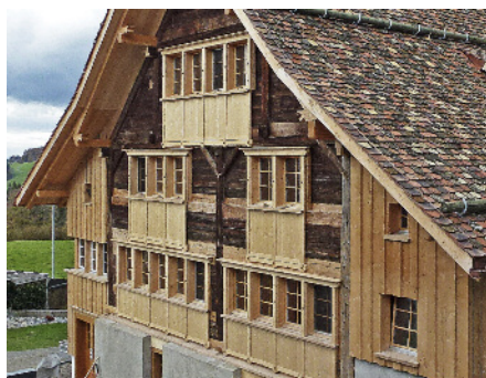
Fassadengestaltung mit rekonstruierten Zugladenkästen.
