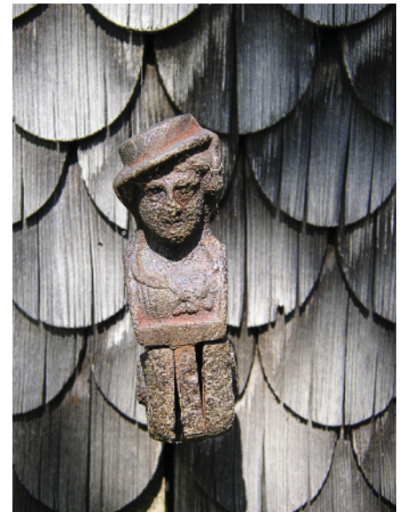
Der Ladenhalter tut auch rostig noch seinen Dienst und ist ein Stück Baugeschichte.
