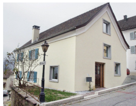
Der rückwärtige Anbau unter gleichem First hebt sich durch moderne Fensteröffnungen vom Altbau ab.
