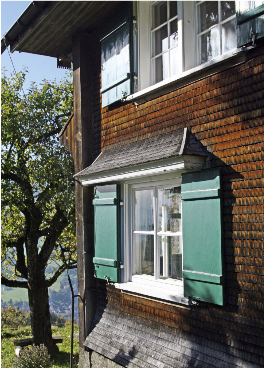
Zum Schmuck der Fassade an diesem Toggenburgerhaus in Ebnet-Kappel gehören die fein geschwungenen Abwürfe über den Fenstern und die hölzernen Schlagläden.
