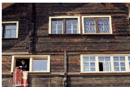
Alte Fenster mit restaurierten alten Verglasungen, neue Öffnungen einfach und ablesbar.
