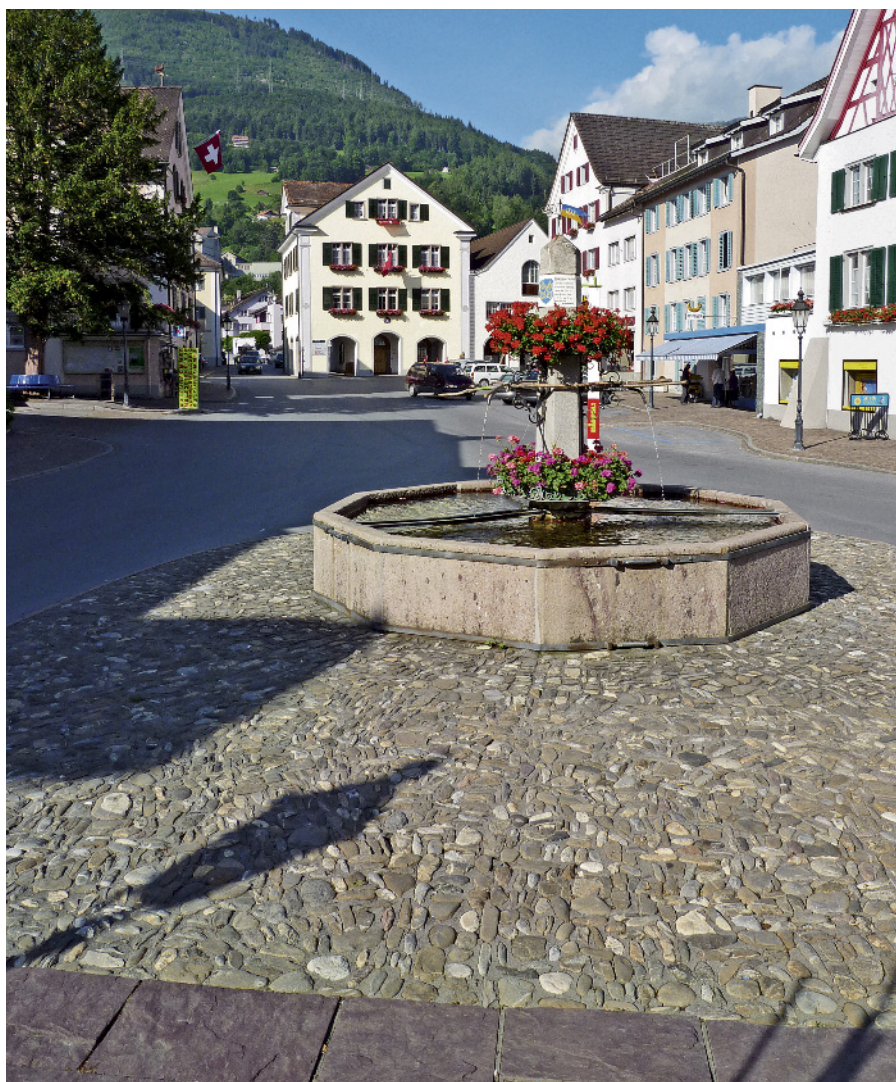
Lokale Verrucano-Platten und Katzenbuckelpflaster geben den Fussgängerbereichen auf dem Dorfplatz Mels eine hohe Wertigkeit.
