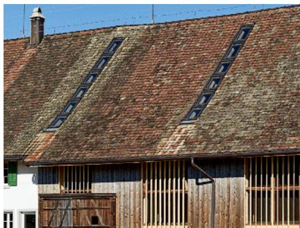
Bei grossflächigen Scheundächern kann sich ein vertikales Lichtband relativ gut integrieren.
