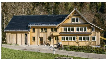
Photovoltaikanlage auf einem nicht geschützten Bauernhaus; die vollflächige Anordnung verleiht dem Stalldach wieder eine Geschlossenheit.
