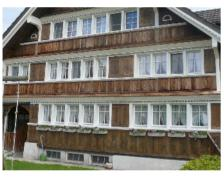
Erhalt der authentischen Fassade mit energetischer Ertüchtigung. Das Fassadentäfer wurde demontiert, 8 cm Zellulose als Isolation eingeblasen und das Täfer mit kleinen Ergänzungen wieder montiert.
