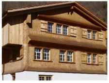
In genauer Rekonstruktion des Vorzustandes wurde der Schindelschirm vollständig erneuert mit den charakteristischen Rundungen um die Gwättköpfe und mit den Vordächern mit Hohlkehlen.
