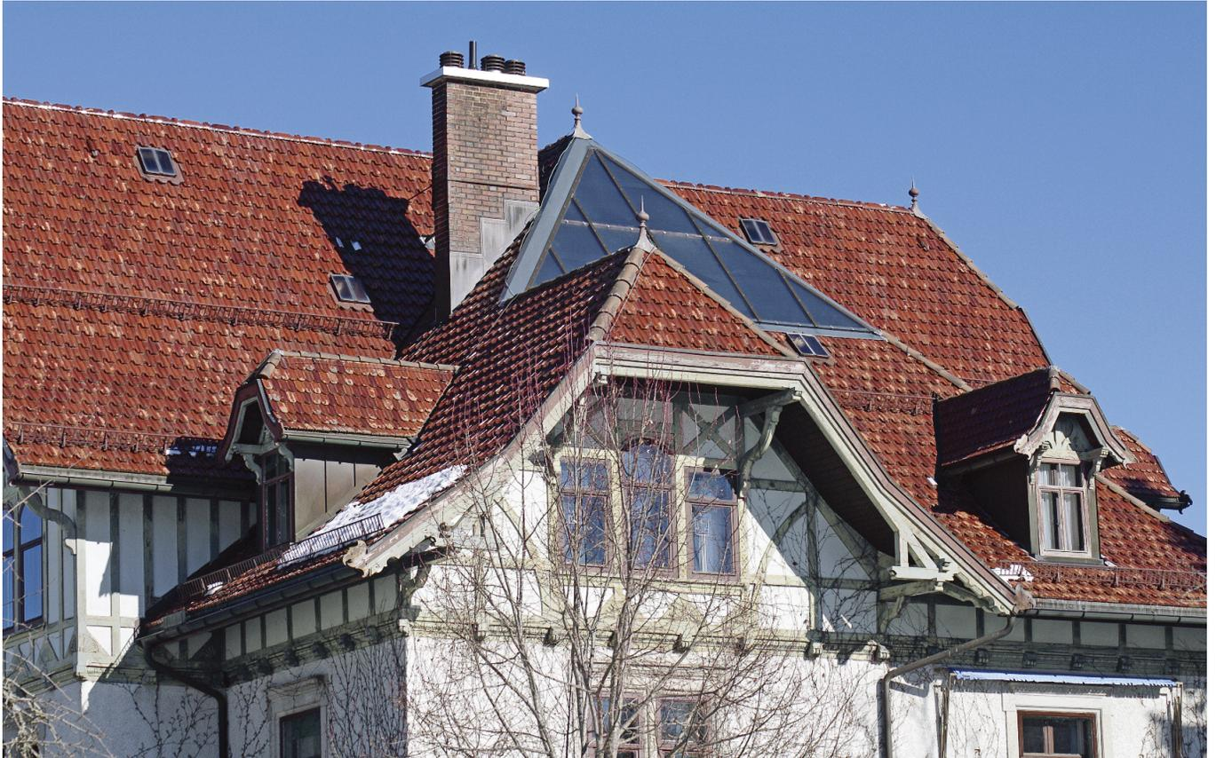
Die thermischen Kollektoren an der Villa Grauer in Degersheim sind so sorgfältig eingefügt, dass sie wie eine alte Atelierverglasung wirken.
