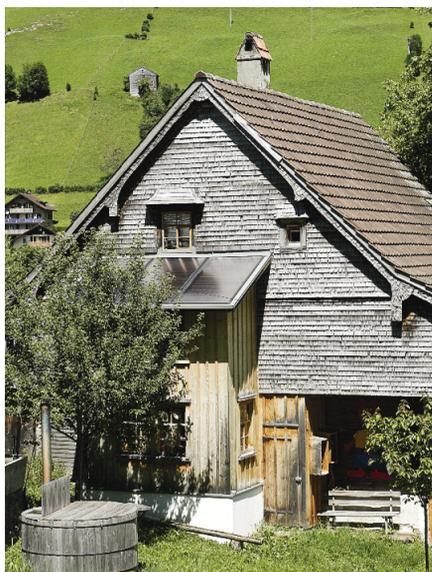
Thermische Kollektoren auf einem Nebendach belassen das Hauptdach intakt.
