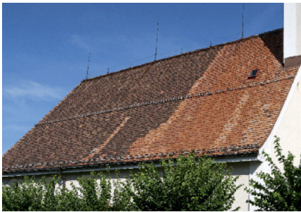
Alte und neue Biberschwanzziegel können vermischt oder nebeneinander verlegt werden. Die naturroten Ziegel erhalten mit der Zeit eine Patina. Alte Blitzableiter bekrönen das Dach.
