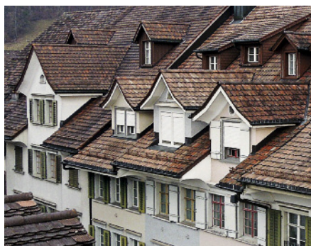
Die neuen Lukarnen (links und rechts) übernehmen die Gestaltung der bestehenden.
