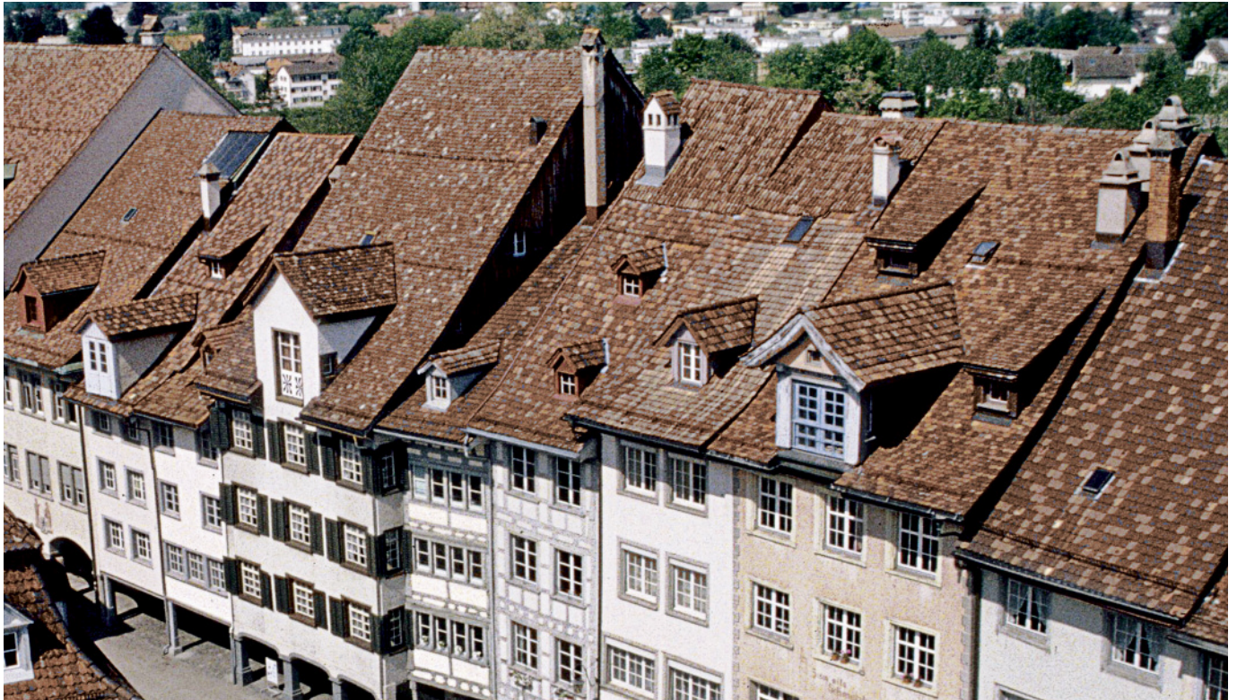
Historische Dachlandschaft in der Wiler Altstadt mit Giebellukarnen im unteren Dachgeschoss, allenfalls Schleppgauben im zweiten Dachgeschoss und ganz selten einem kleinen Spenglerfenster. Die Lukarnen, die die Traufe unterbrechen, stammen von alten Aufzugsvorrichtungen.
