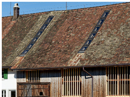
Bei grossflächigen Scheunendächern kann sich ein vertikales Lichtband relativ gut integrieren.
