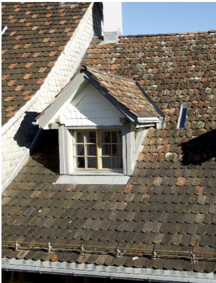
Feingliedrige Dachabschlüsse mit Ziegelleisten, Schneefang als Stange; die Spenglerarbeiten in Kupfertitanzink passen zu den grau gestrichenen Architekturelementen.
