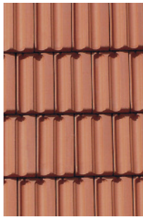
Herzfalzziegel oder Muldenziegel sind frühe Industrieziegel mit stark reliefierter Oberfläche. Sie sind vor allem auf ländlichen Bauten und Bauten aus der 2. Hälfte des 19. Jh. verbreitet.
