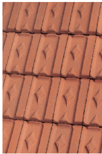
Herzfalzziegel oder Muldenziegel sind frühe Industrieziegel mit stark reliefierter Oberfläche. Sie sind vor allem auf ländlichen Bauten und Bauten aus der 2. Hälfte des 19. Jh. verbreitet.
