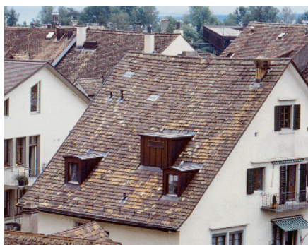
Neue kleine Lukarnen mit Kupferverkleidung.
