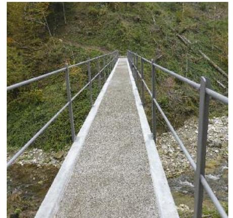
Ein künstliches Gefälle auf der sonst horizontalen Brückenoberfläche sorgt für eine funktionierende Entwässerung.
