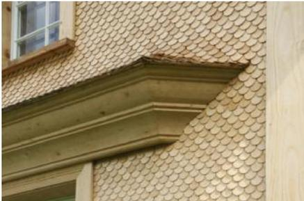
Die Schindelfassade mit den schmalen, aber sehr schmucken profilierten Abwürfen wurde bis ins Detail wiederhergestellt.
