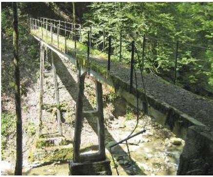
Das Fundament der südlichen Stütze war leicht gekippt und mit einem Zuganker gesichert.
