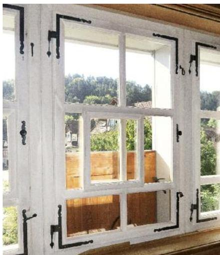
Nachbau Schieberfenster mit Isolierverglasung.
