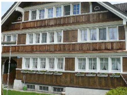
Erhalt der authentischen Fassade mit energetischer Ertüchtigung. Das Fassadentäfer wurde demontiert, 8 cm Zellulose als Isolation eingeblasen und das Täfer mit kleinen Ergänzungen wieder montiert.
