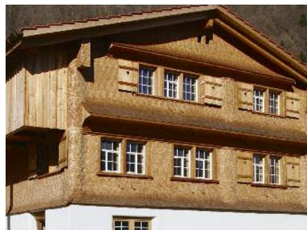
In genauer Rekonstruktion des Vorzustandes wurde der Schindelschirm vollständig erneuert mit den charakteristischen Rundungen um die Gwättköpfe und mit den Vordächern mit Hohlkehlen.
