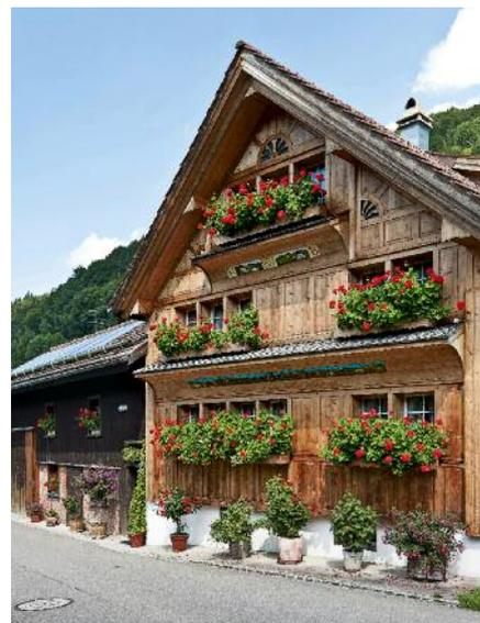
Die Kollektoren im Stalldach werden durch den hölzernen Schneefang kaschiert.
