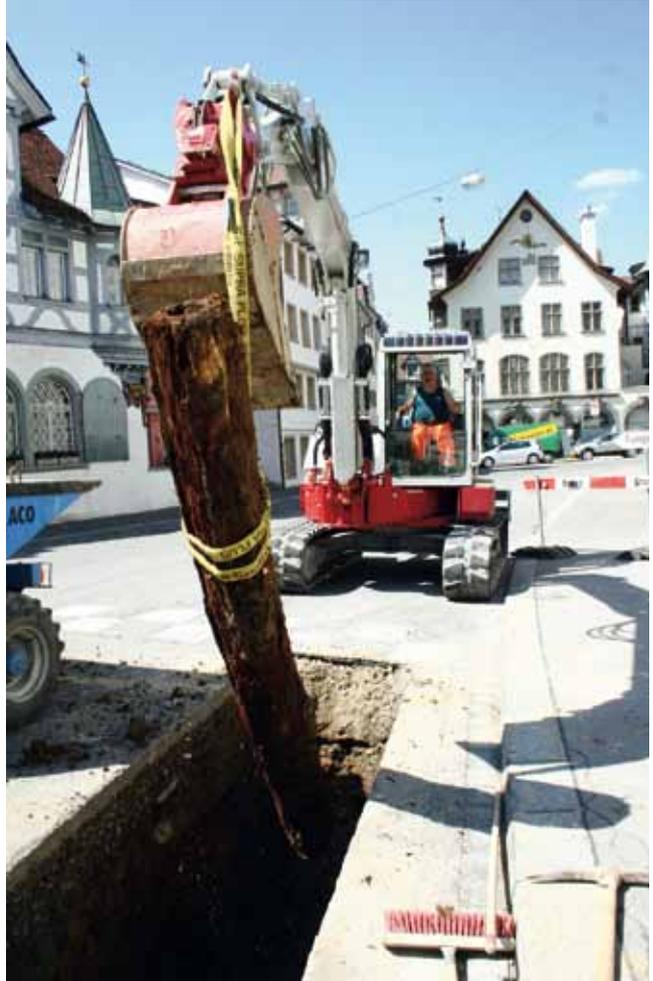
St.Gallen, Gallusstrasse 2008. Ein neuzeitlicher Teuchel wird vom Bagger gehoben. Foto KA SG.
