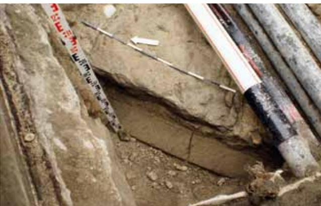
St.Gallen, Grünerturm. 2010 Ansicht des Fundamentsockels aus grossen, sorgfältig zugerichteten Sandsteinblöcken. Foto KA SG.
