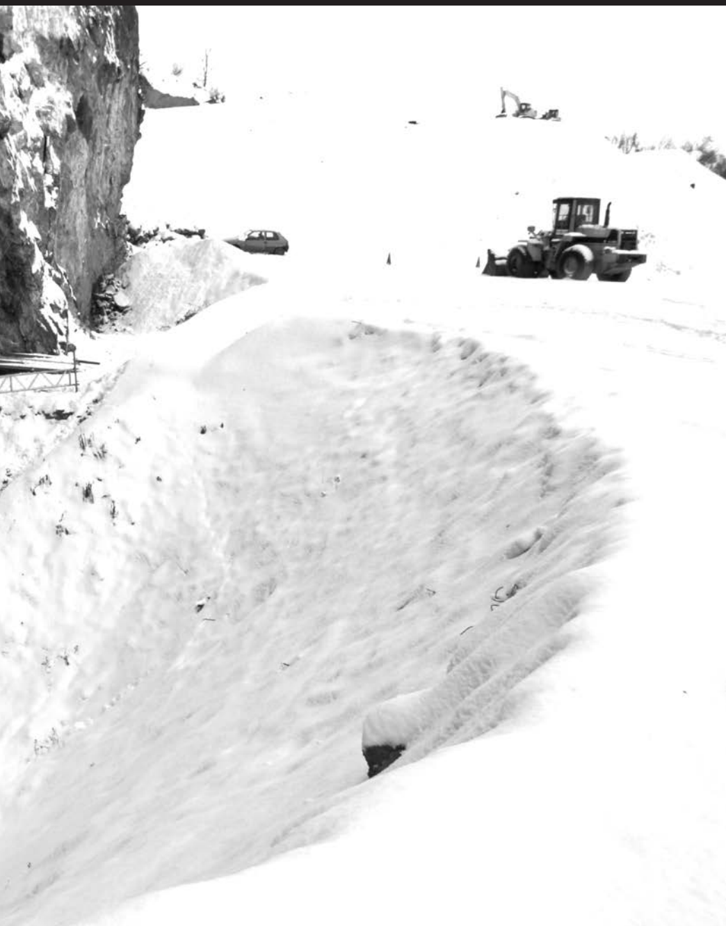
Die durch Bauprojekte bedingten Einsätze der Kantonsarchäologie finden ganzjährig, wie hier in Oberriet, statt. KASG
