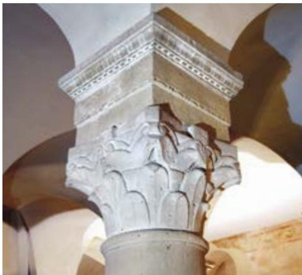
**Abb. 95** Corvey D, Erdgeschoss Westbau. Kapitell (H 58 cm) mit Kämpfer (H 29 cm) und Deckplatte (H 20 cm). Um 880.
