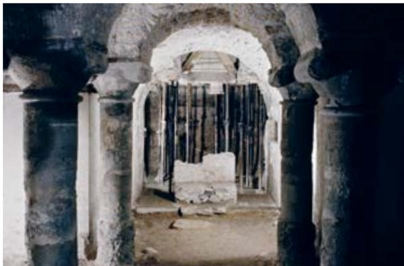
**Abb. 30** West-/Otmarskrypta, gegen Osten. Zustand links vor und rechts während der Bauarbeiten 1963/64. Auf der Aufnahme vor dem Umbau sind gut die hohen Sockel der Säulen zu erkennen. Ebenso ist abzulesen, dass die Schäfte aus Trommeln gefügt waren. Schliesslich heben sich die Ergänzungen an den Polsterkapitellen deutlich ab.
