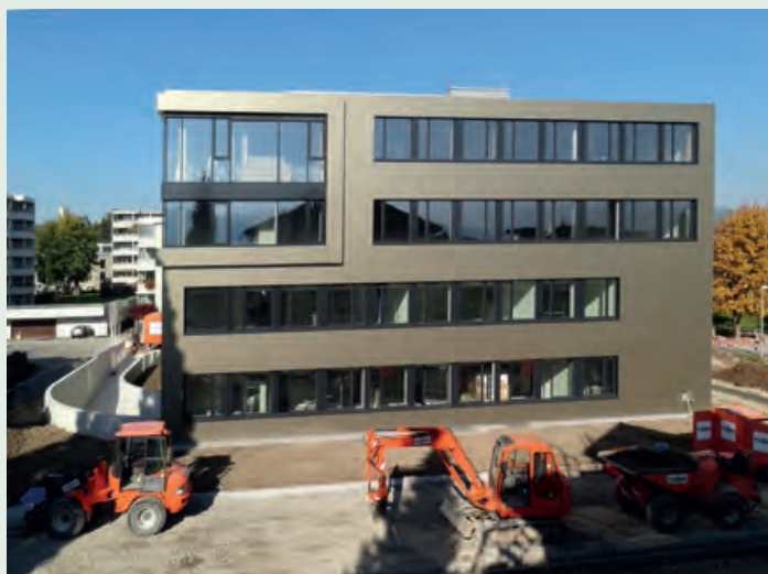
Nach nicht einmal einem Jahr Planungs- und Bauzeit stand das Bürogebäude.
