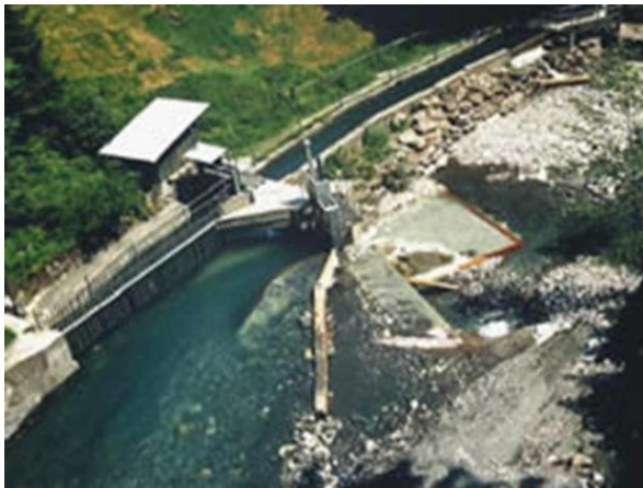
Abbildung 7: Kraftwerk Tobel im Normalbetrieb.
