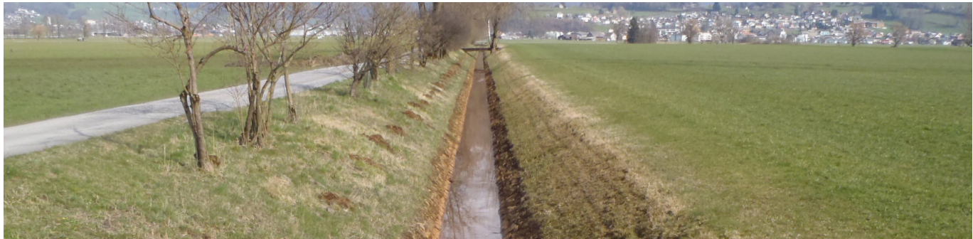
Der Kanal K mit Blick gegen die Fliessrichtung
