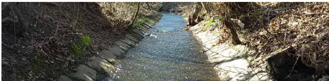
Fluetskanal im Bereich vor der Mündung in die Uze
