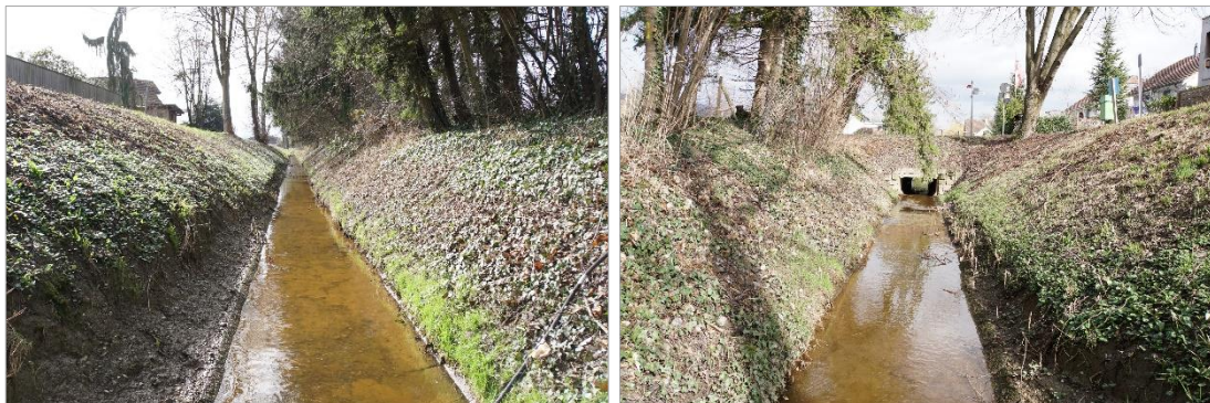
Abb. 26: Links: Blick aufwärts; rechts: Blick abwärts
