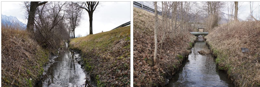
Abb. 16: Links: Blick aufwärts; rechts: Blick abwärts
