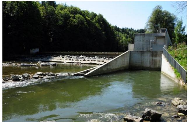
Abbildung 82: Wehr des KW Burentobel vom Unterwasser aus gesehen. In der Bildmitte ist der Eingang zum Fischpass zu sehen.
