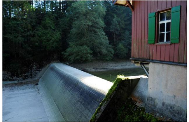
Abbildung 86: Dem Wehr List fehlt eine Fischaufstiegsanlage. Es ist für Fische in Richtung stromaufwärts nicht passierbar,
