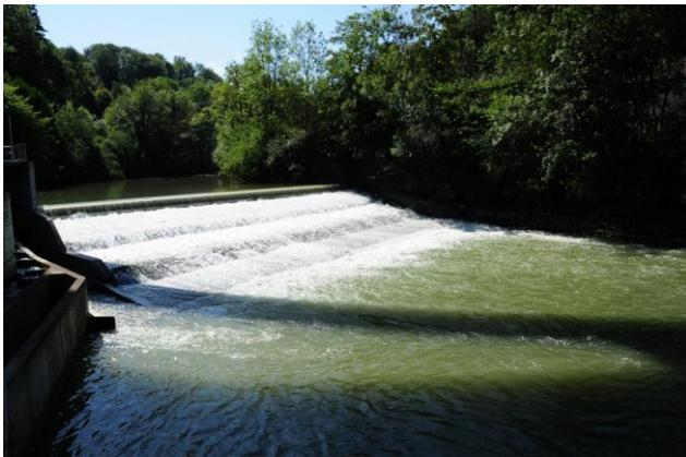
Abbildung 81: Wehr des KW Sitterthal vom Unterwasser aus betrachtet. Links im Bild der Eingang zum Fischpass.
