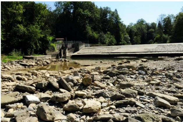
Abbildung 83: Das Wehr des KW Erlenholz bei Sunk vom Unterwasser aus gesehen. Auf der linken Seite ist die Fischaufstiegsanlage zu sehen.
