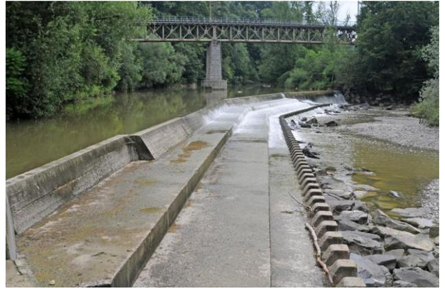
Abbildung 80: Wehr Sitterdorf bei leichter Überströmung.
