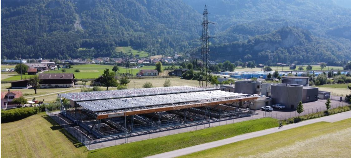
Abb. 23: ARA Flums-Seez mit Solarfaltdach (Quelle: ARA Flums-Seez)
