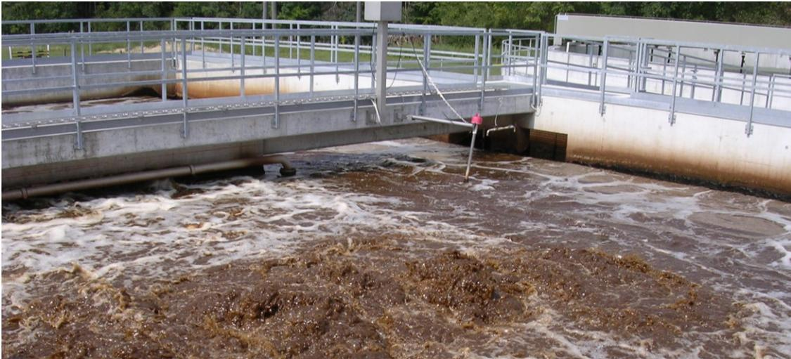
Abb. 6: Belebtschlammbecken in Belüftungsphase (Quelle: AWE)
