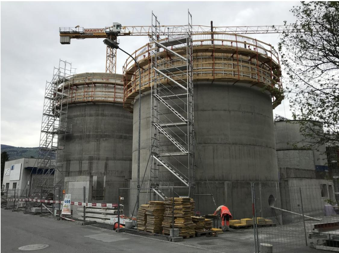
Abb. 19: Bau neuer Faultürme der ARA Buchs im Jahr 2019 (Quelle: AWE)
