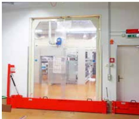
Halbautomatische und manuelle Löschwasserbarriere
