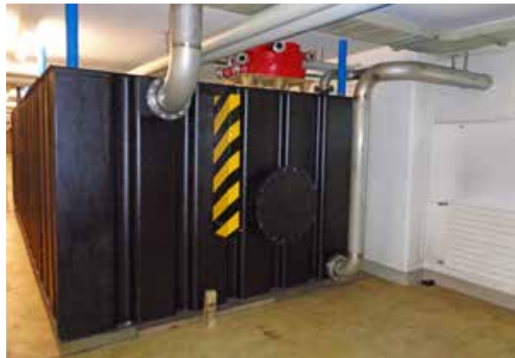
Löschwasserauffangbecken
