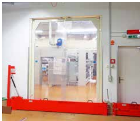
Halbautomatische und manuelle Löschwasserbarriere
