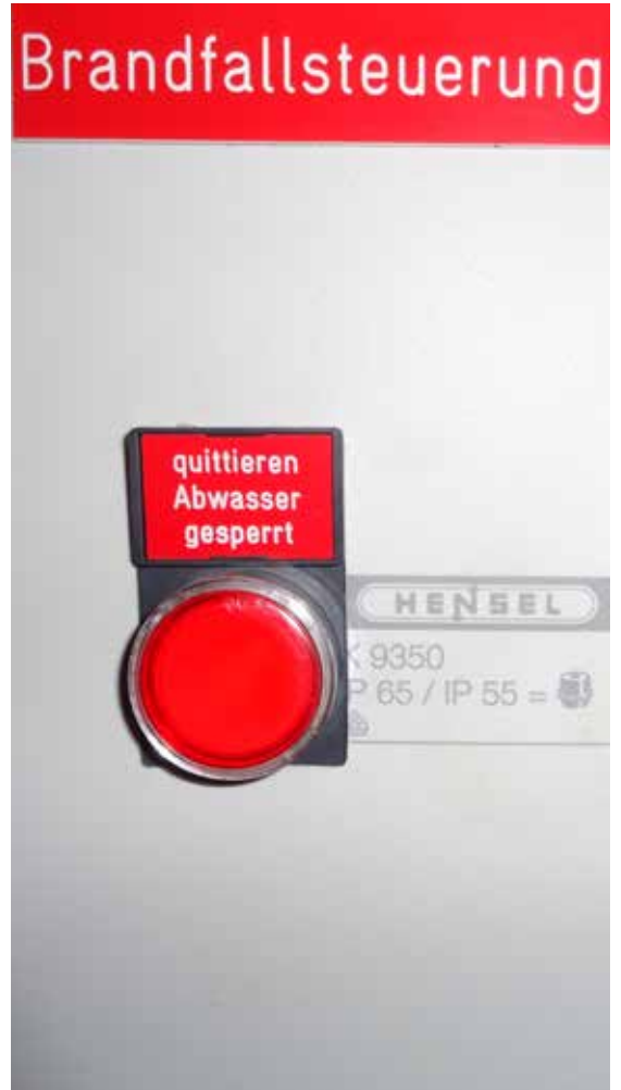
Brandmeldegesteuerte Abwasserhebeanlage
