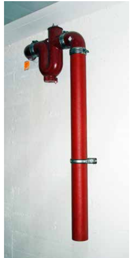
Löschwasserablauf aus Obergeschoss
