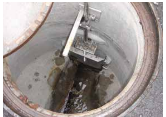
Schiebersystem für Kanalisation
