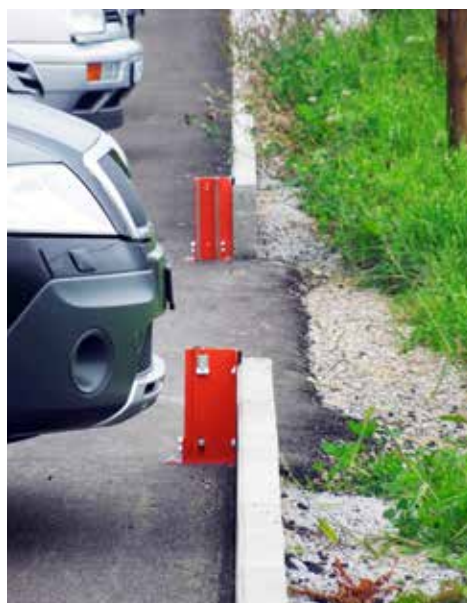
Manuell steckbare Löschwasserbarriere auf Vorplatz
