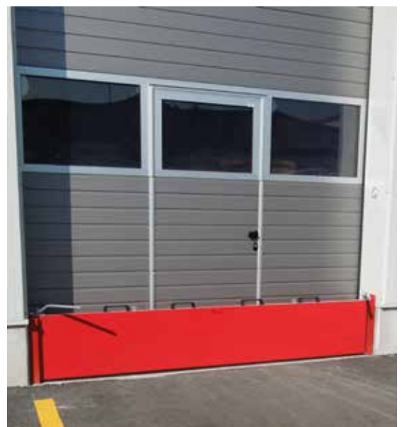
Manuell steckbare Löschwasserbarriere
