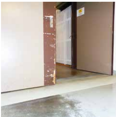
Anrampung bei Durchgängen
