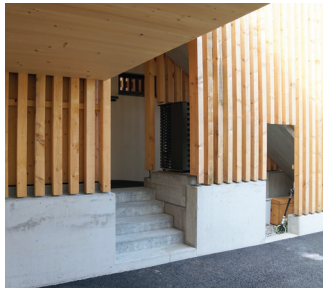
Beispiel Neubau Einfamilienhaus in Heiligkreuz, Mels Schutz durch erhöhte Bauweise
