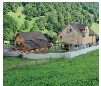
Mels, Weissstannental Schutzmauer gegen Murgang
