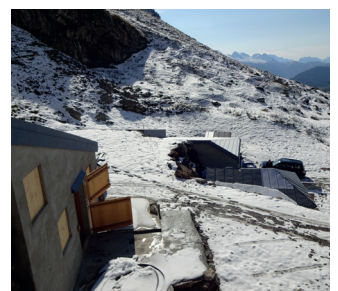
Wildhaus, Schutz vor Lawinen Öffnungen im Winter verschlossen und verstärkt
