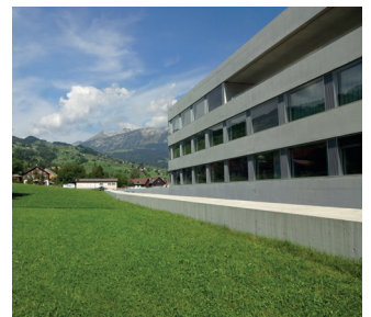
Grabs, Schutzmauer Spital Murgang Studnerbach
