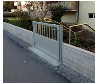
Altstätten, Arealschutz Abschirmung mit Mauer und Tor
