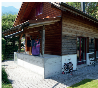
Beispiel bestehendes Gebäude Ferienhaus in Unterterzen Hochwasserschutz am Gebäude
