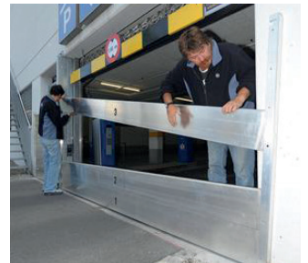
Steinach, Bodenseehochwasser Mobiles Dammbalkensystem
