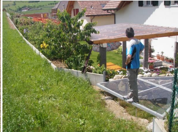
Abbildung 2: Stellriemen und Einlaufbauwerk, erstellt nach dem Ereignis
