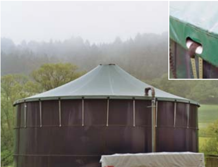
Abb. 10: Zeltdach in biaxialer Form der Firma Ceno-Tec (D). Die Folie ist mit Lochbändern am Silo angeschraubt.
