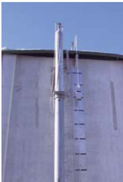
Abb. 23: Durch eine von aussen sichtbare und funktionssichere Füllstandsanzeige werden viele Kontrollgänge auf dem Güllenbehälter vermieden. Sie trägt damit zur Reduktion der Unfallrisiken bei.
