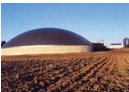
Abb. 14: Siloabdeckung der Firma Epa-Canada. Die Abdeckung hat die Form einer Kugelkappe und wird über dem Behälter aufgeblasen.
