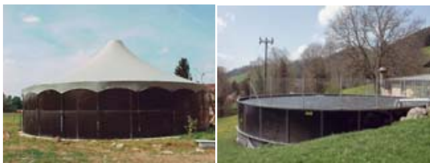
Abb. 1: Zwei bewährte Güllensiloabdeckungen: links Zeltdach mit zentraler Stütze, rechts seitlich geführte Schwimmfolie.
