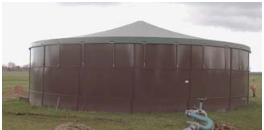
Abb. 12: Zeltdach der Firma PAS. Im Saum der Plane verläuft ringsherum ein Rohr, woran Spanngurte mit Ratschen befestigt werden.
