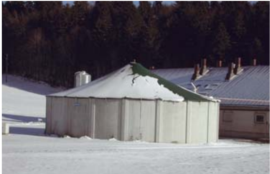
Abb. 9: Damit Schneeverfrachtungen oder einseitige Schneeschmelze keine Schäden verursachen, muss die Zeltabdeckung entsprechend nachgespannt werden. In schneereichen Gebieten stossen Zeltabdeckungen auf Stahlbehältern bezüglich Lastübertragung an Grenzen.
