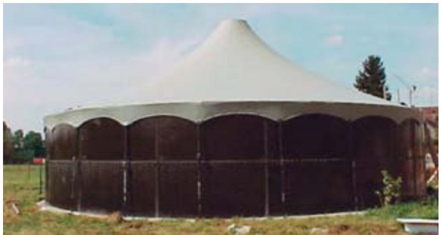
Abb. 11: Zeltdach der Firma Bieri-Kohli. Die Spanngurten sind direkt an der Plane befestigt.
