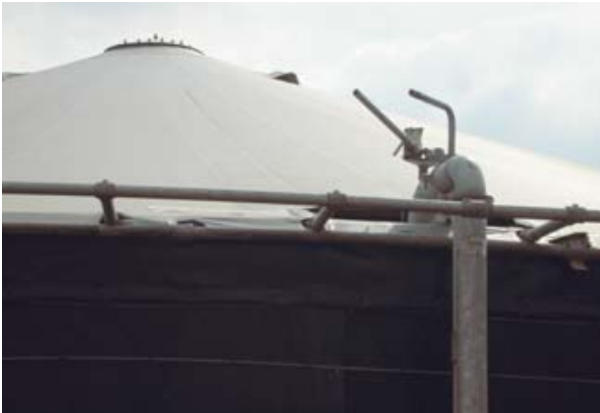
Abb. 13: Zeltdach der Firma Milieutechnieken (NL). Die Entlüftungsöffnungen sind in der Plane integriert.
