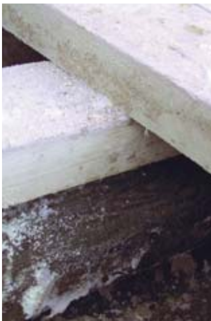
Abb. 16: Die Holzabdeckung ist mit Querhölzern versteift, die zusätzlich mit PE-Rohren als Schwimmhilfe versehen sind.
