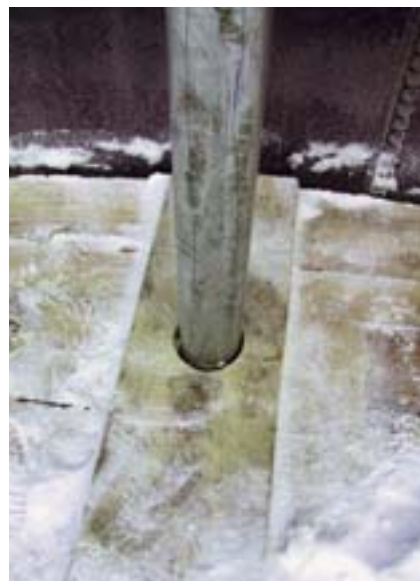
Abb. 17: Zwei gegenüberliegend montierte Stabilitätsrohre sichern die Abdeckung gegen Drehen. Dadurch können die Aussparungen für Rührwerk, Befüll- und Entnahmeleitungen minimal ausgeführt werden.
