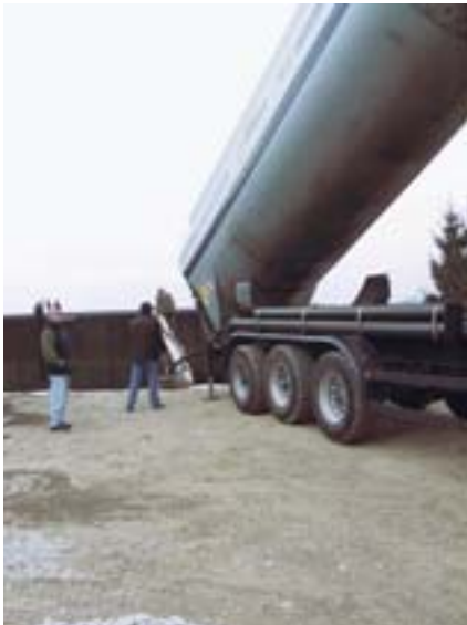
Abb. 19: Der Blähton wird beim ersten Befüllen direkt ab Werk mit Silowagen geliefert und in den Behälter eingeblassen.
