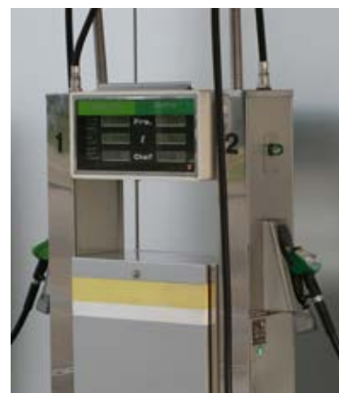
Alle Benzintankstellen müssen mit Gaspendelungen ausgerüstet sein.
