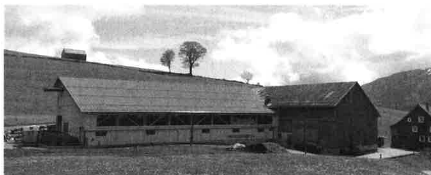
Anbau Rindviehscheune; Familie Huber, Burst, Alt St. Johann
