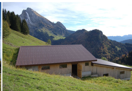
Neubau Alpstall Oberlauri, Alt St. Johann
