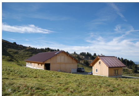
Neubau Alpstall und Hütte Breitenalp, Alt St. Johann
