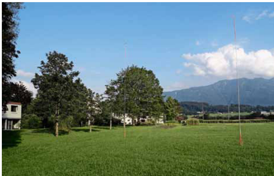
Bauvisiere für den Neubau des LZSG in Salez
