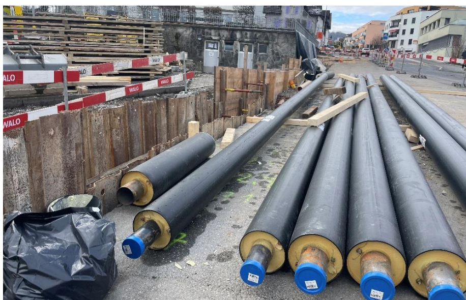
Einbau der Fernwärmeleitungen im Ortskern von Eschenbach
