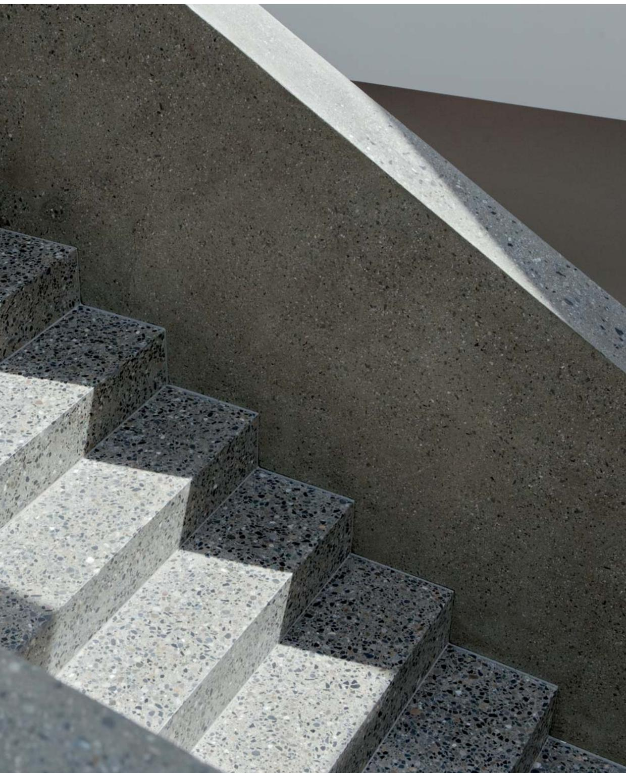
Brüstung in Beton eingefärbt, geschliffen
