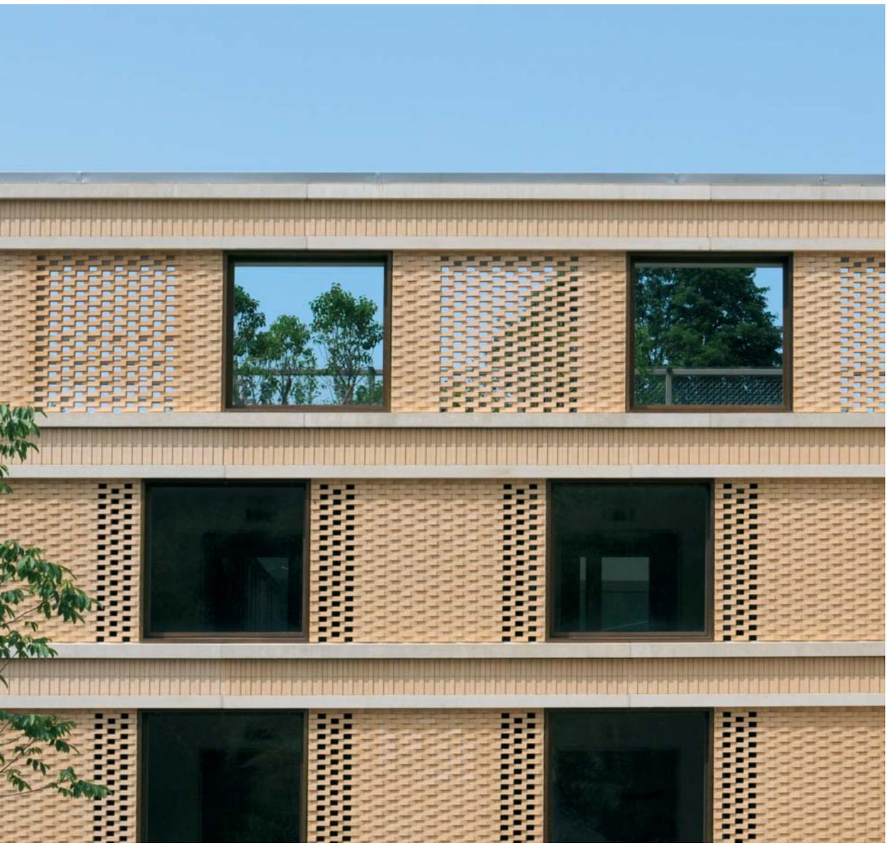
**Oben: Klinkersteinfassade hergestellt mit Tonerde aus dem Fricktal in einer speziell für dieses Gebäude entwickelten Verarbeitung.**
