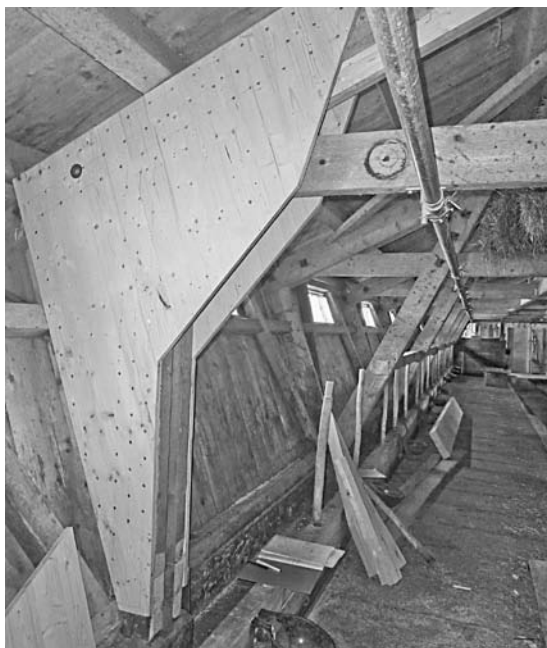
Musterstall auf der Säntisalp: Die schräge Stütze (im Hintergrund sichtbar) wurde auf andere Art und Weise abgefangen, sodass der Kopfbereich der Kühe frei bleibt; nun können die Standplätze problemlos verbreitert werden.
