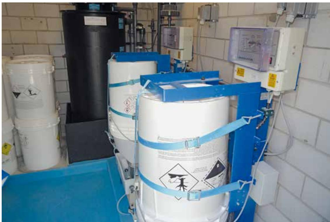
*Das Risiko für unerwünschte Oxihalogenide im Badewasser hängt vom Desinfektionsverfahren ab. Bei Anlagen mit Calciumhypochlorit als Desinfektionsmittel, wie hier abgebildet, gab es keine Beanstandungen.*
