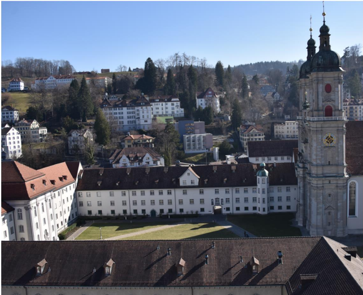
Abb. 3: Der Hofflügel, zwischen Neuer Pfalz (Regierungsgebäude) und Kathedrale
