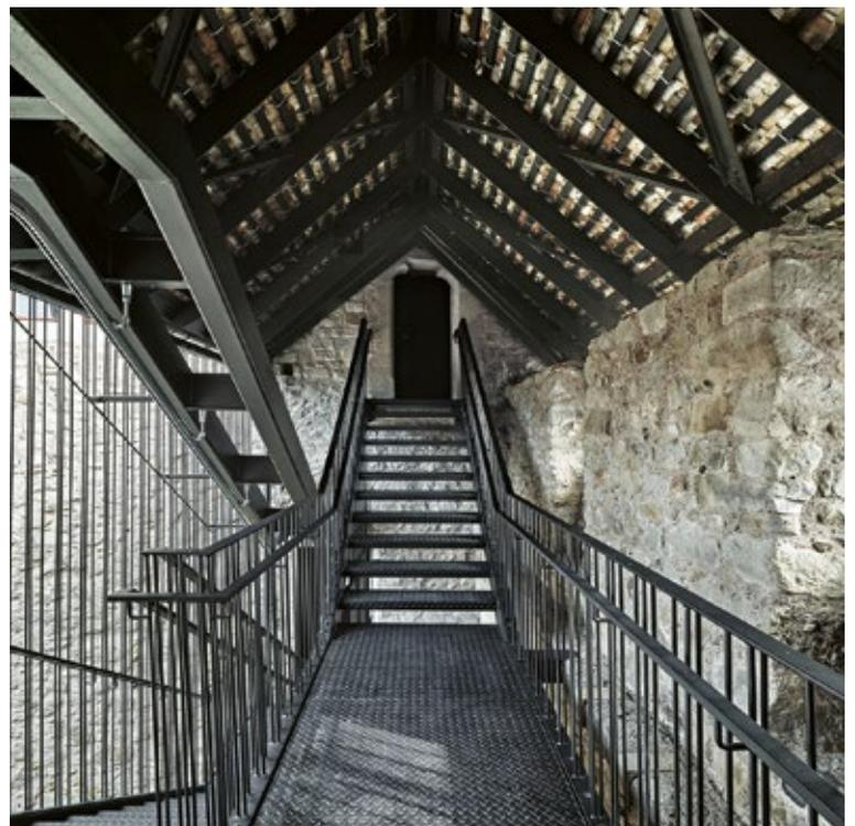
Der Gügelerturm und die neue Fluchttreppe samt Wehrgang in Stahlkonstruktion.
