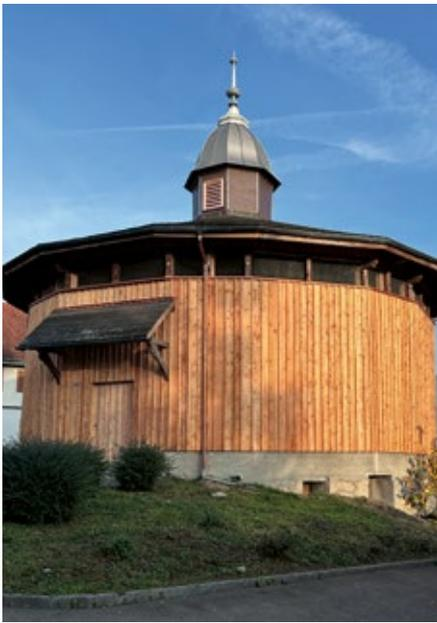
Der Pavillon wurde mit einem Deckleistentäfer vor der Witterung geschützt und erfüllt so wieder optimal das Bedürfnis nach einem Veloabstellraum.
