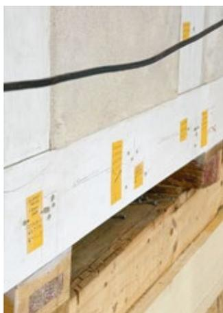
Die neuen Gefache erhielten einen von Hand aufgetragenen Kalkmörtel. Die Sondagelöcher wurden mit NC-Cellulose und Ölkitt verschlossen.
