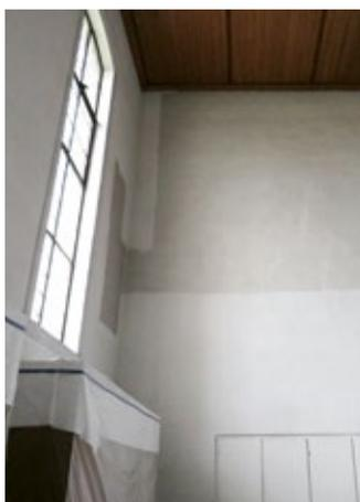
Die Innenreinigung zeigt Wirkung: oben Vorzustand, unten nach der Reinigung.
