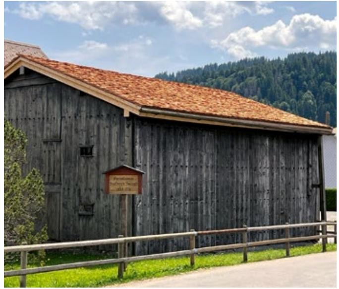
Rückansicht des Gebäudes nach der Dachsanierung; auf die zusätzliche Beschwerung der Schindeln mit Steinen zu Schauzwecken wurde aus technischen Gründen verzichtet.
