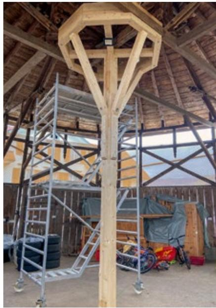
Das Gewicht des Daches und des Türmchens konnte durch eine neu eingesetzte Mittelstütze abgefangen werden.
