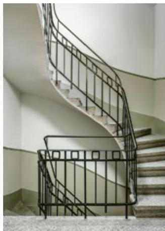
Das bauzeitlich erhaltene Treppenhaus mit neuer Geländererhöhung und Farbigekeit nach Befund.
