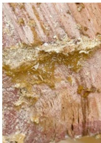
Die stetige Kondensierung innerhalb der Gebäudehülle hatte zu ausgedehntem Befall mit Hausschwamm geführt.
