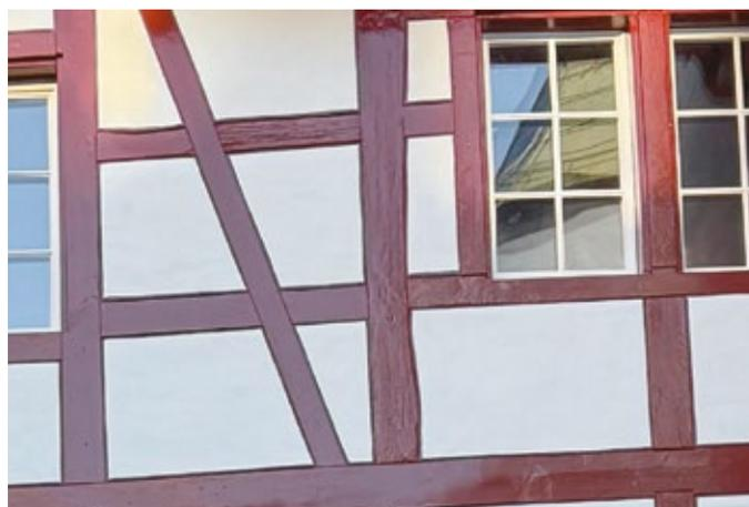
Endzustand. Das Holzwerk wurde in Ölfarbe, die Gefache mit einer Silikatfarbe auf der Basis von Kaliwasserglas gefasst.
