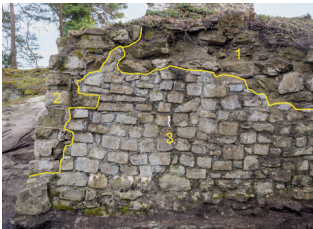
17: Mauer M1, Maueraussenmantel, von Norden. 1: Originaler, oberflächlich stark abgewitterter Mauermantel. 2: 1937 mit aus dem Mauerschutt geborgenen Buckelquadern reparierter Eckverband M1/M2. 3: Grössere nach 1938 aufgeführte Reparatur des äusseren Mauermantels. Die einheitlich kantig zugehauenen Sandsteinquader wurden nicht wie das originale Mauerwerk der Burg im näheren Umfeld abgebaut, sondern von anderswo herangeführt.
