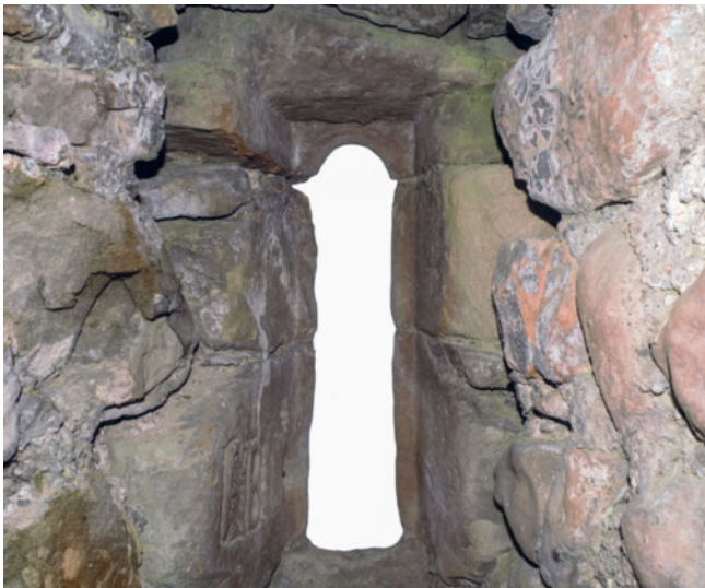
22: Mauer M2. Innenansicht des äusseren Gewändes des Fensters M2.1, von Westen. Das in der Bauhütte vorfabrizierte, lediglich aus sechs Hausteinen bestehende Gewände ist oberflächlich stark brandgerötet. Links ist der eiserne Dorn des unteren, abgebrochenen Klobens zum Einhängen eines Fensterladens hinter den rezent eingeritzten Initialen FB noch knapp zu erkennen.
