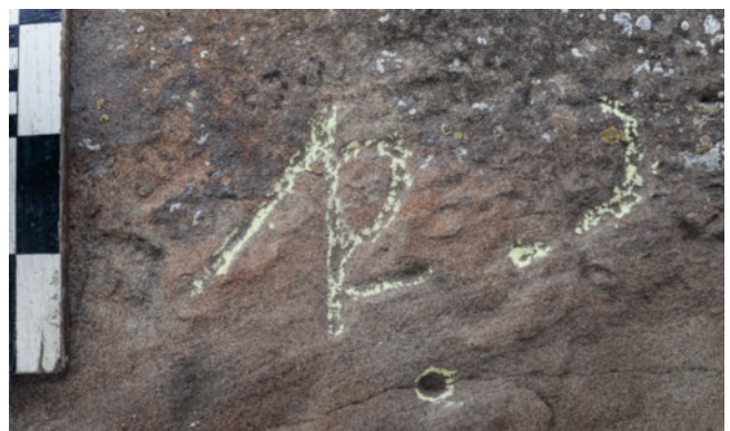
23: Mauer M2. Steinmetzzeichen 7.4, eingehauen in den drittuntersten Sandsteinquader des Eckverbandes M2.2, mit Kreide nachgezeichnet, von Norden. Das unterhalb des Zeichens zu erkennende kreisförmige Loch ist vermutlich der Rest eines verwitterten Zangenlochs.
