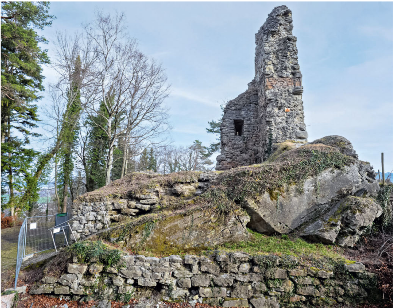
9: Ruine des Turms mit dem hochaufragenden «Eckzahn» M2/M3 vor Beginn der Sanierungsarbeiten 2023, von Westen. Im Vordergrund zu sehen ist die entlang der östlichen Flanke des Halsgrabens verlaufende Mauer M17.
