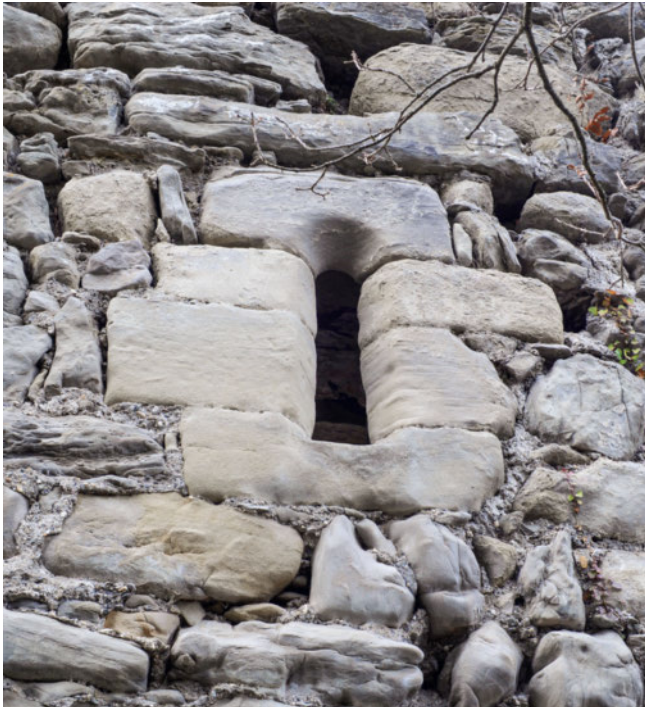
21: Mauer M2, Fenster M2.1, von Osten. Aussenansicht des originalen, gut erhaltenen, rundbogigen Gewändes aus grauem Sandstein.
