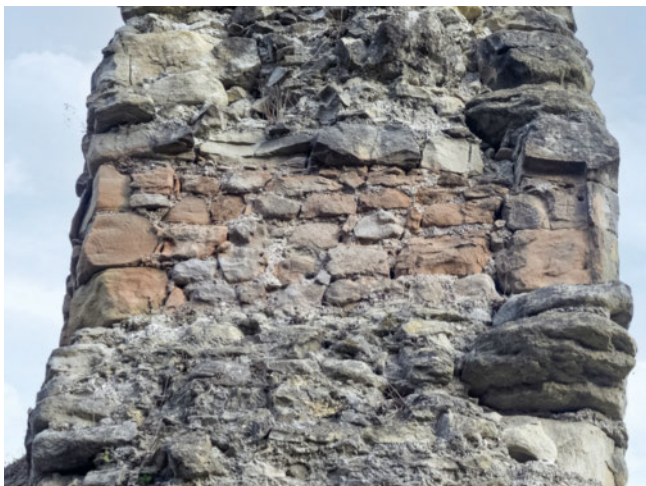
26: Mauer M3. Östliche Leibung des Fensters M3.1 stark brandgerötet, von Westen. Die Fensterlnische ist gegen aussen konisch zulaufend. Die Bruchfläche ober- und unterhalb des Fensters ist nicht brandgerötet. Die gezielte Zerstörung des Turms kann deshalb erst nach dem Brand erfolgt sein.
