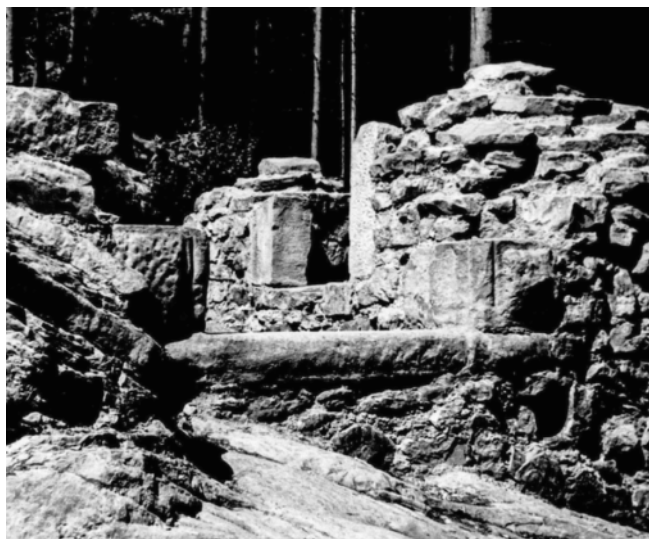
34: Inneres Tor (Tor 2), Zustand nach dessen Freilegung 1936, von Osten. Erkennbar sind im Vordergrund die Schwelle und zwei bossierte würfelförmige Gewändesteine. Dahinter liegt die Türe 1, Zugang zum langrechteckigen Gebäude, welches an den nördlichen Ringmauerabschnitt M5 anlehnt ist.
