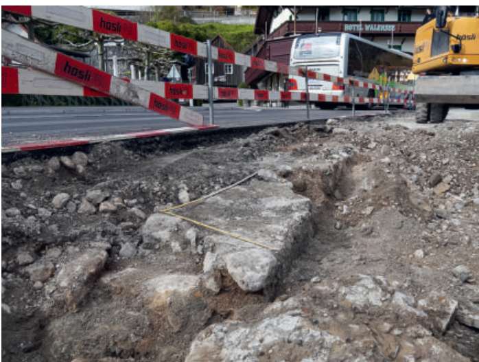
Weesen, Hauptstrasse. Südliche Aussenmauer der alten Sust, Blick gegen Norden. Foto KASG.
